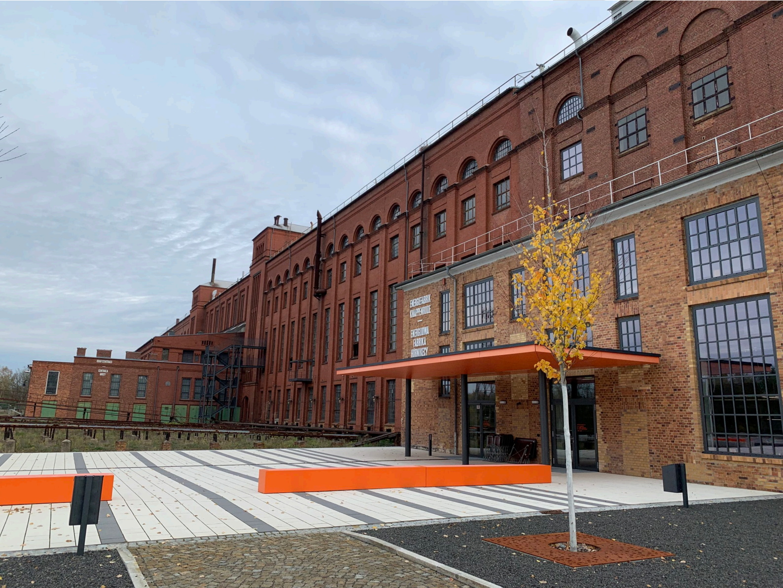
Eingangsbereich der Energiefabrik Knappenrode im November 2022
