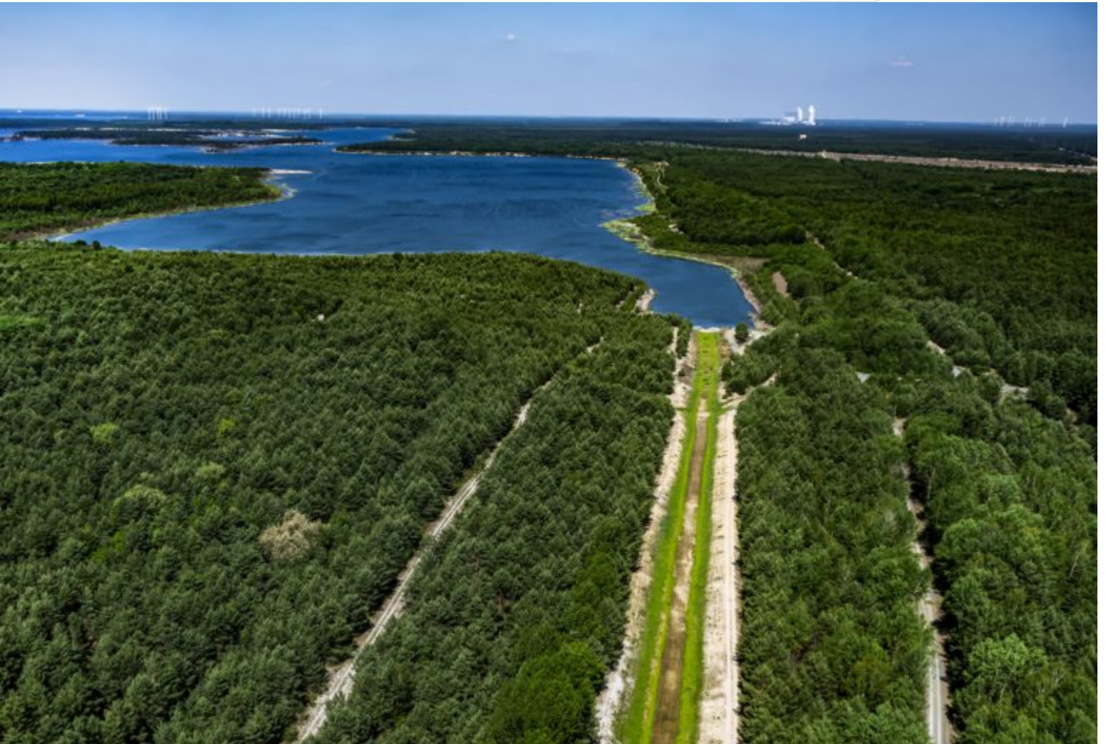
Zulauf-Anlage für den Speicher Lohsa II
