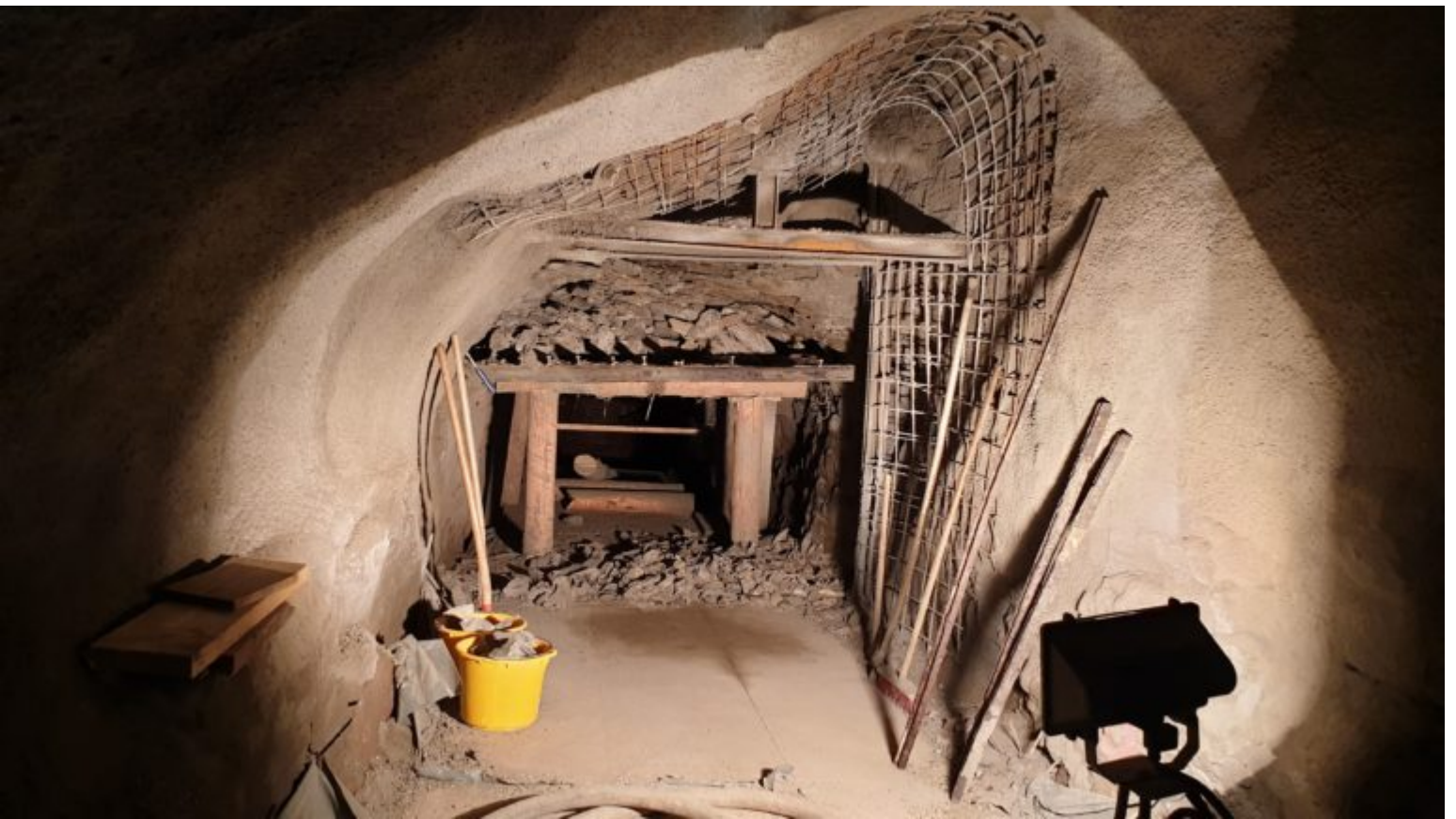
Hergestellter Ausbau in Blickrichtung Schlüsselstollen
