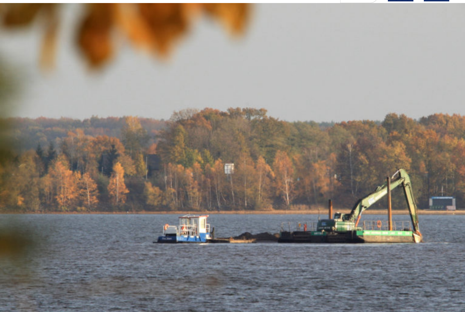
Schwimmbagger der Fa. ETK bei Sofortmaßnahme Teil 2
