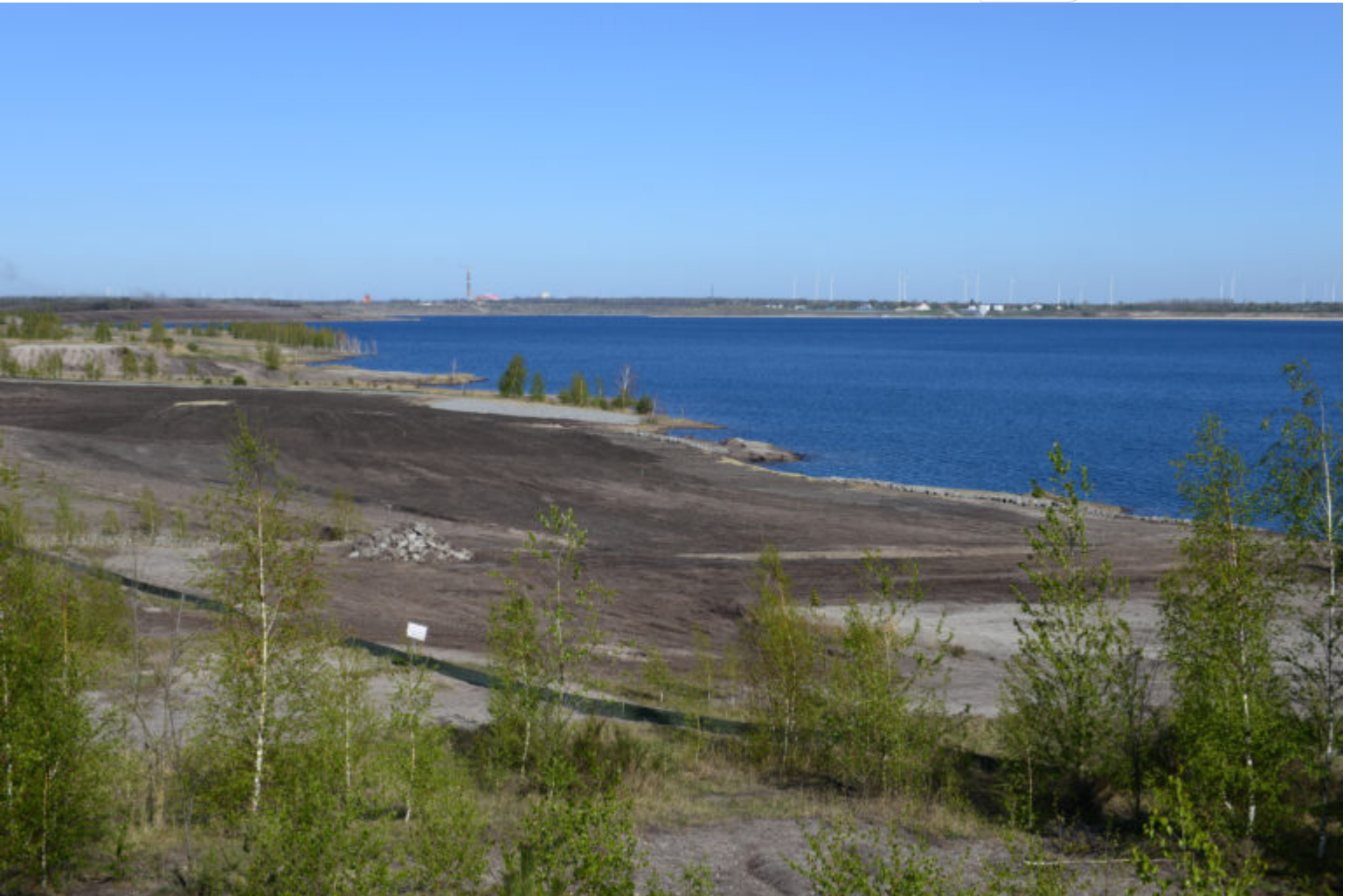
Sichtbare Ergebnisse der Böschungs-Endgestaltung am Großräschener See
