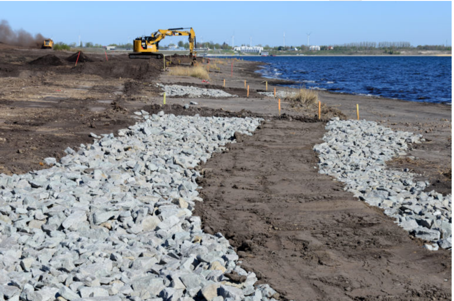
Böschungsendgestaltung am See
