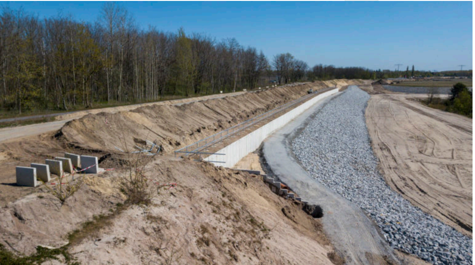
Erfolgter Uferverbau – Sedlitzer See
