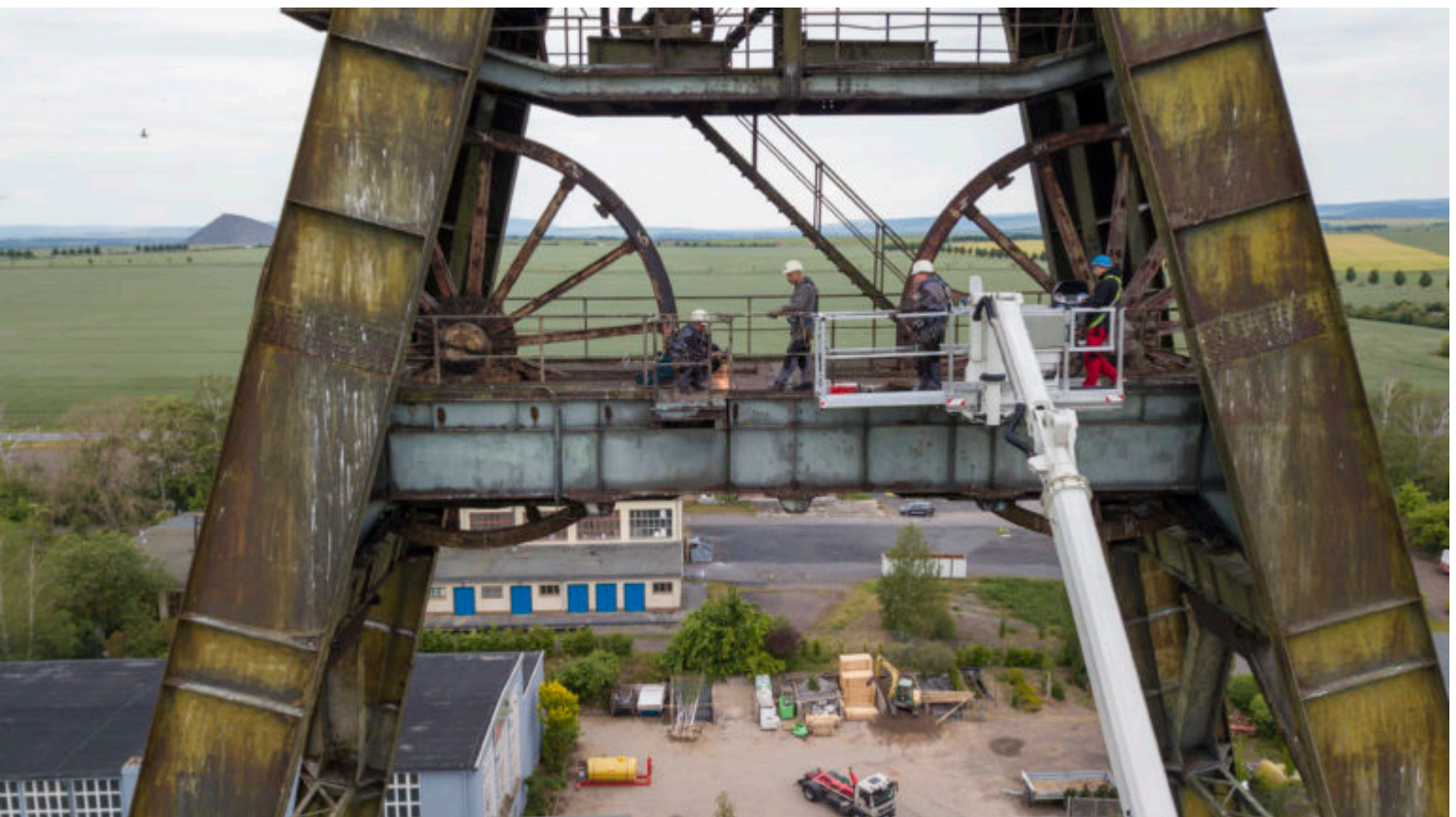
Sicherungsarbeiten auf der unteren Seilscheibenbühne des Fördergerüsts Nienstedt
