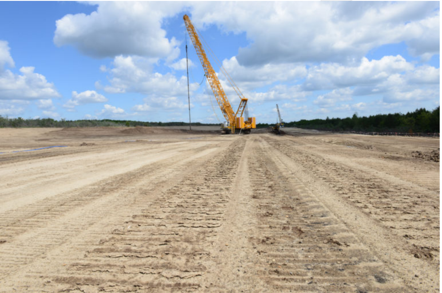
Bereits verdichteter Bereich
