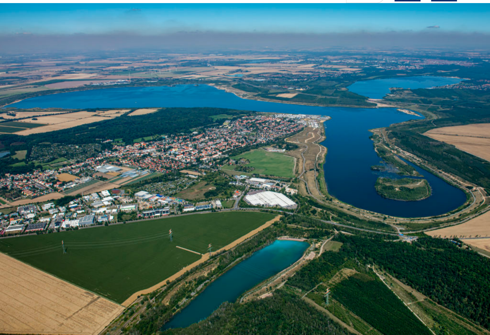
Impressionen vom Bau der Steganlage
