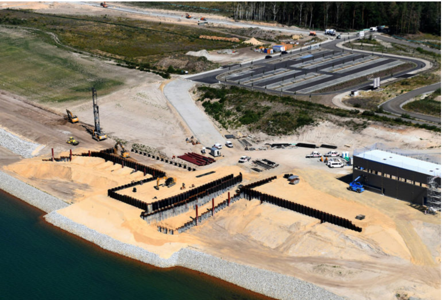
Sanierungsstützpunkt im Bau
