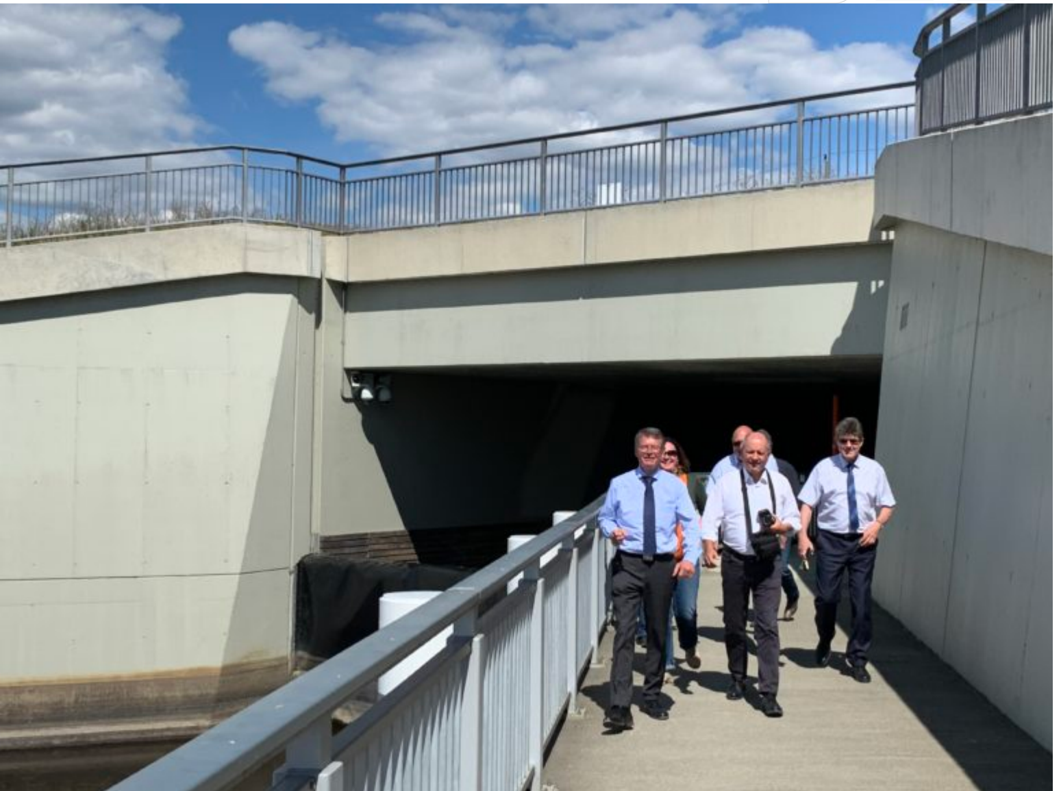
Am Tunnel des Überleiters 11
