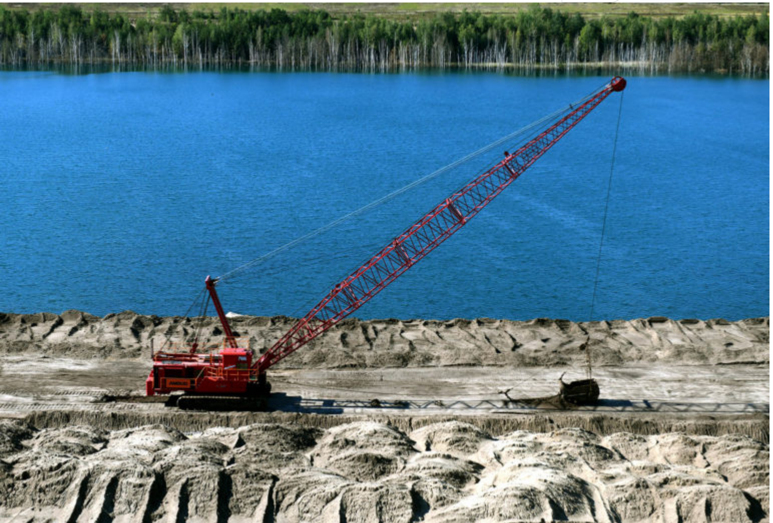
Seilbagger am Ufer des Klinger Sees
