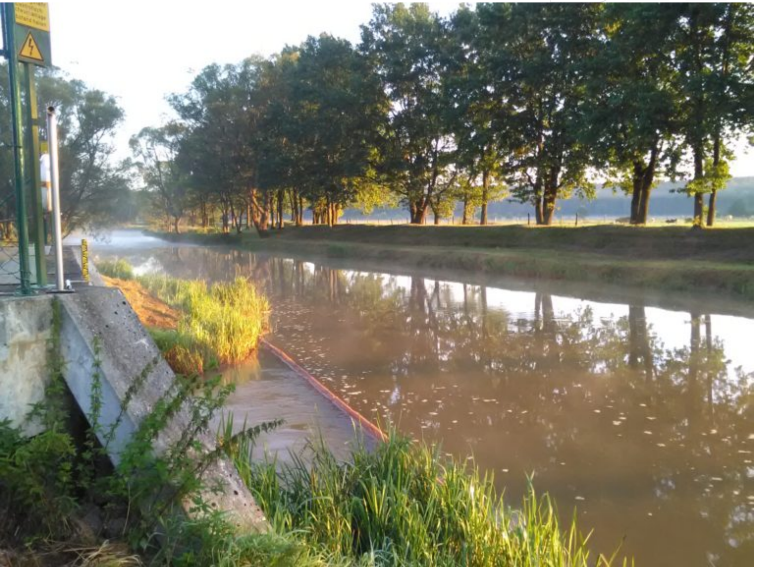
Symbolfoto: LMBV-Abnahmebauwerk an der Spree bei Spreewitz
