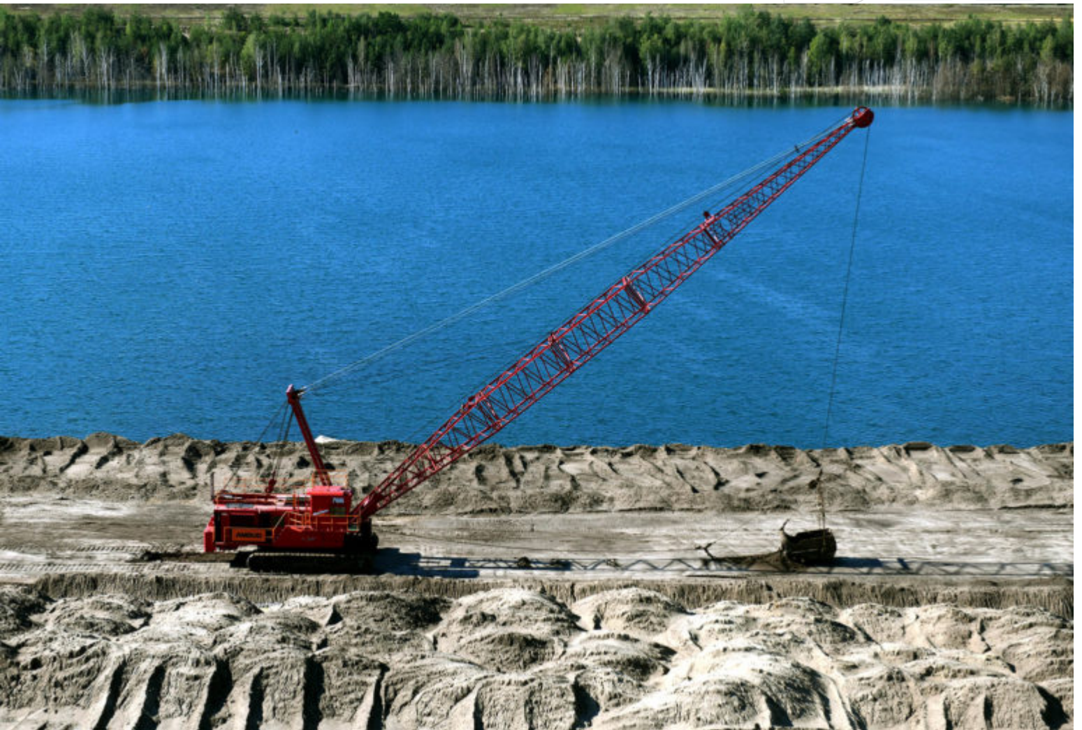
Seilbagger am Ufer des Klinger Sees
