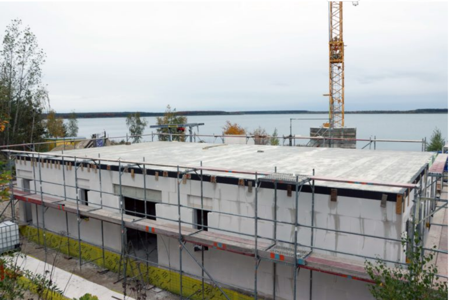
Der Rohbau des neuen Multifunktionsgebäudes
