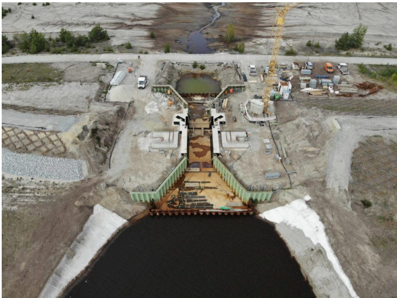
Impressionen vom Bauvorhaben Überleiter 3 a
