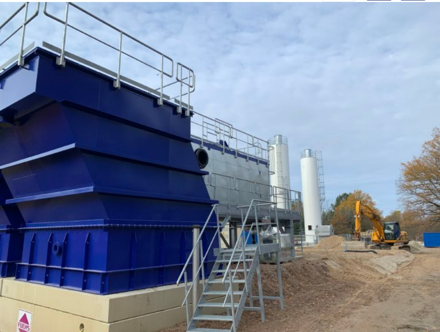
Sichtbarer Baufortschritt | MWBA Ruhlmühle
