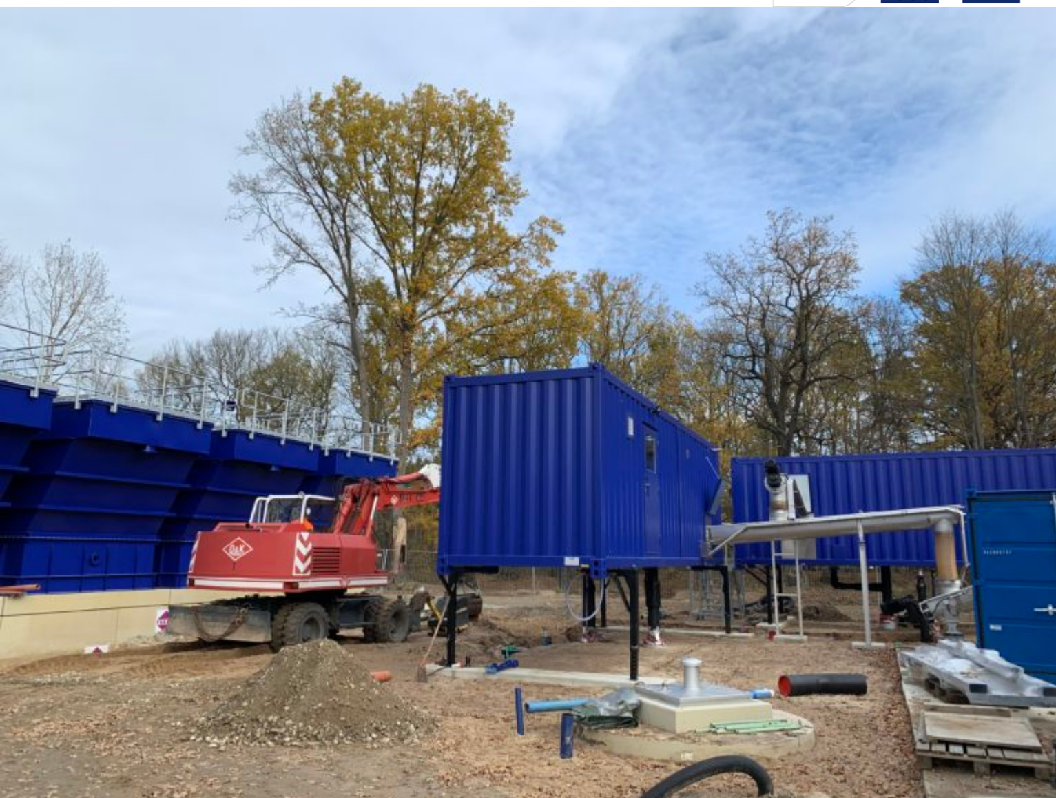
Modulare Bauweise | Ruhlmühl-Baustelle
