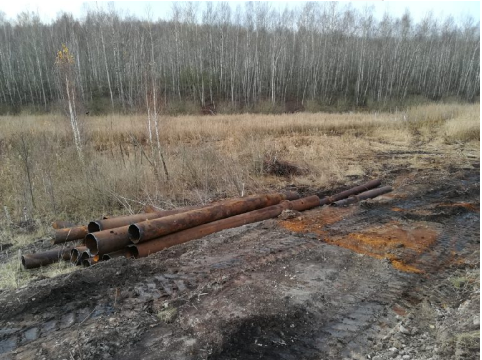
Impressionen von den Arbeiten bei Zechau
