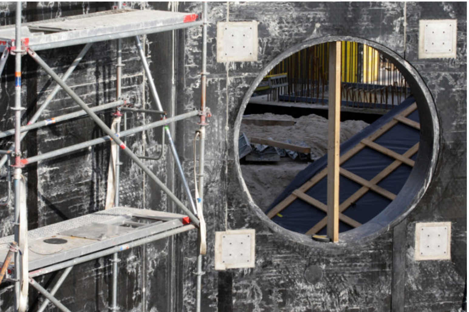
Durchlass für die künftige Rohwasserleitung
