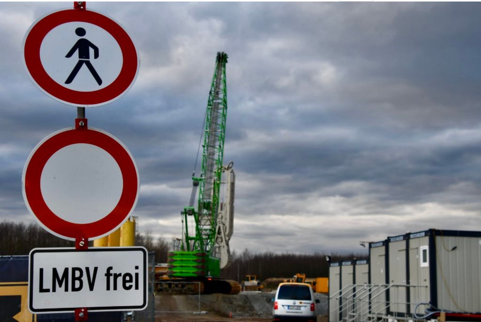
Schlitzwandbaustelle am Zwenkauer See
