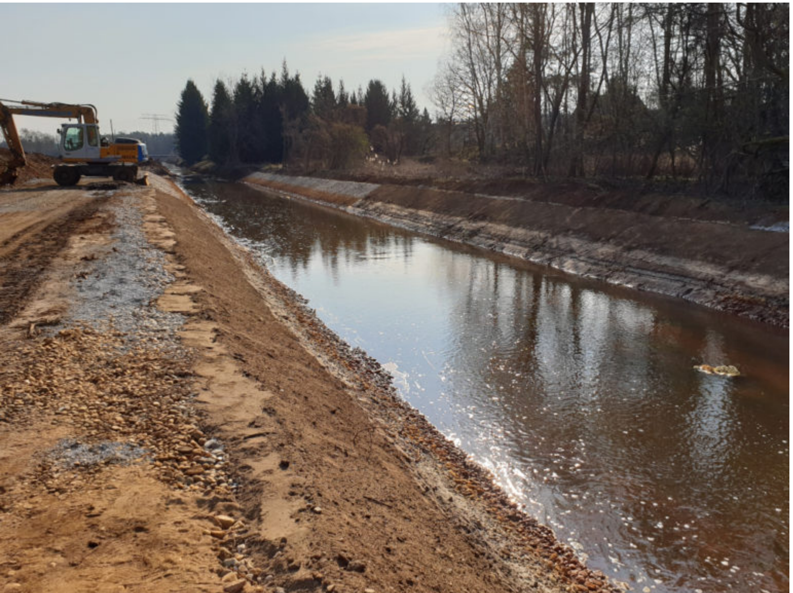
Uferausbau an der Kleinen Spree
