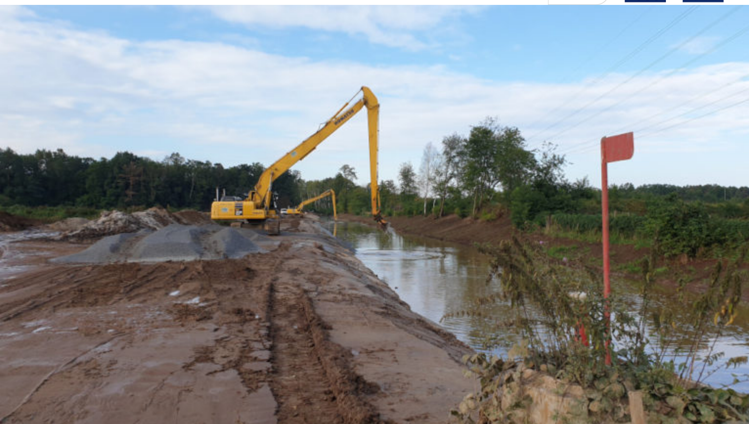
Einseitiger Ausbau der Kleinen Spree
