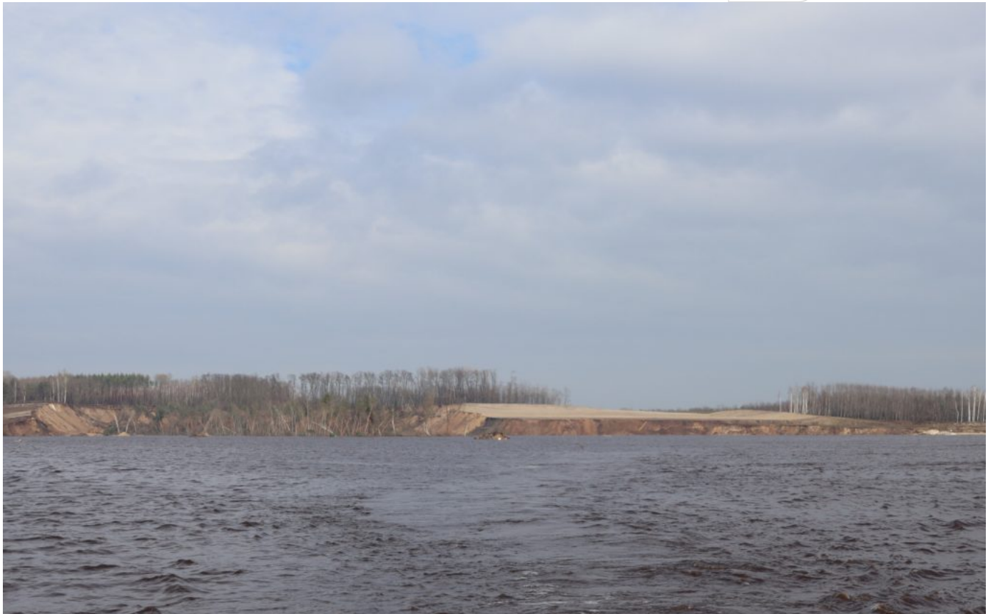
Archivaufnahme der Sanierung
