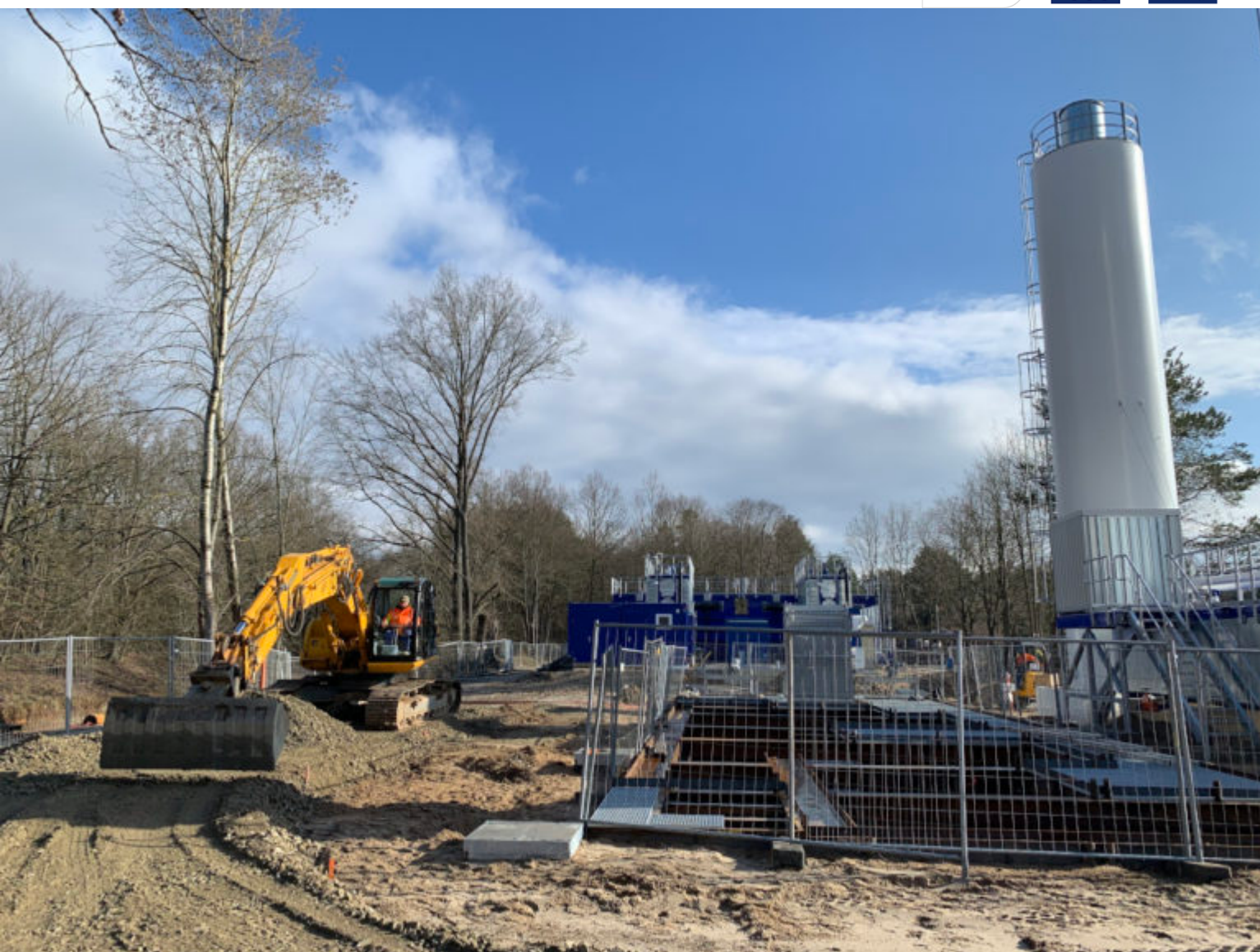
Baufortschritt auf der MWBA-Baustelle
