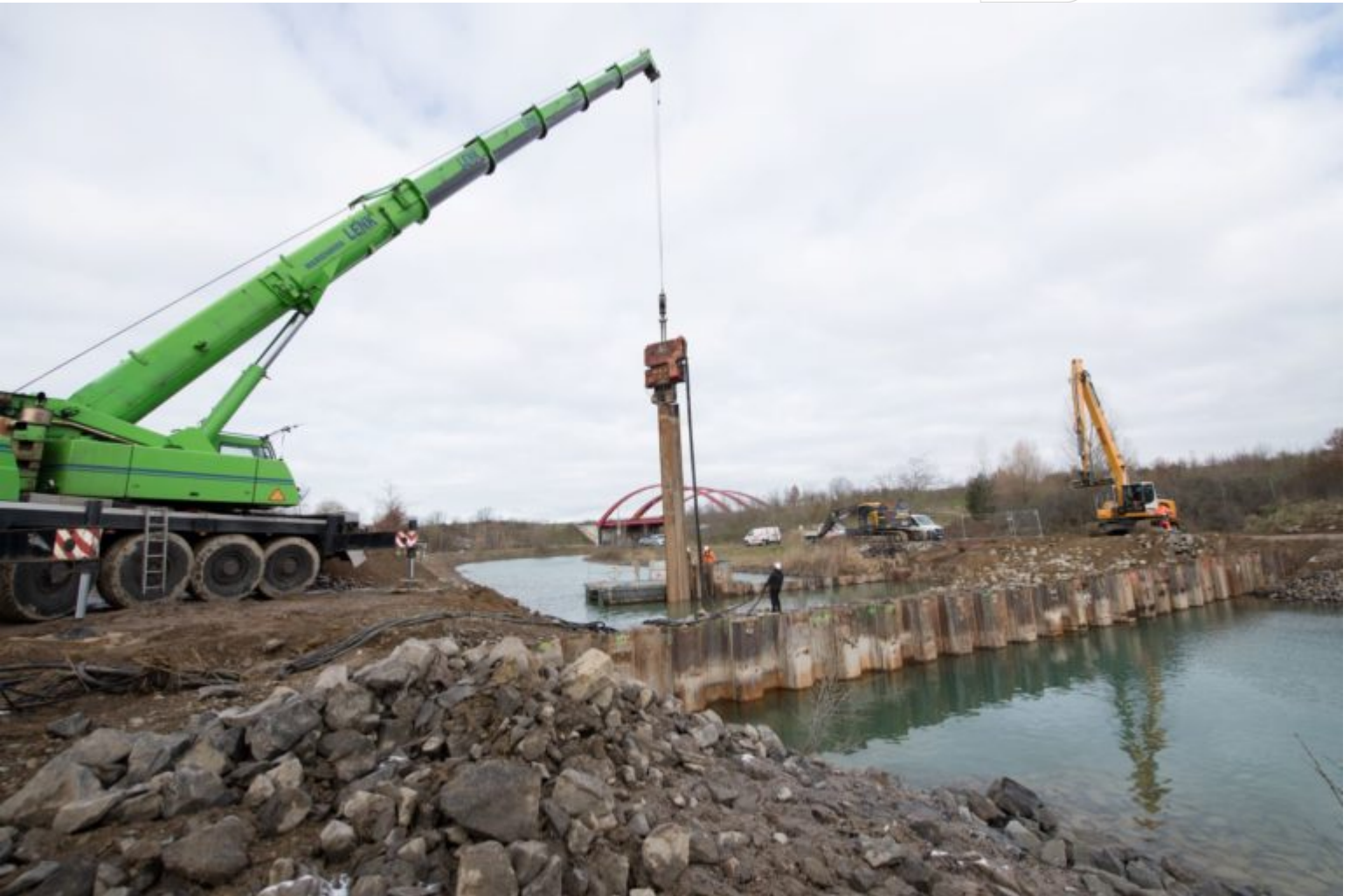
Oberer Spundwandriegel am Störmthaler Kanal im Entstehen
