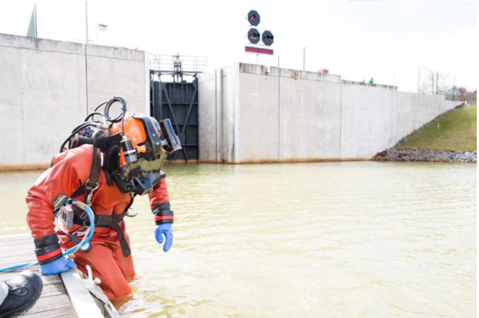
Kontrolltauchgang am unteren Schleusenvorhof am 07.04 2021
