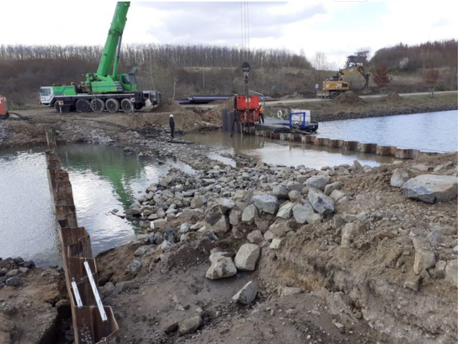
Schrittweisees Auffüllen zwischen den Spundwänden
