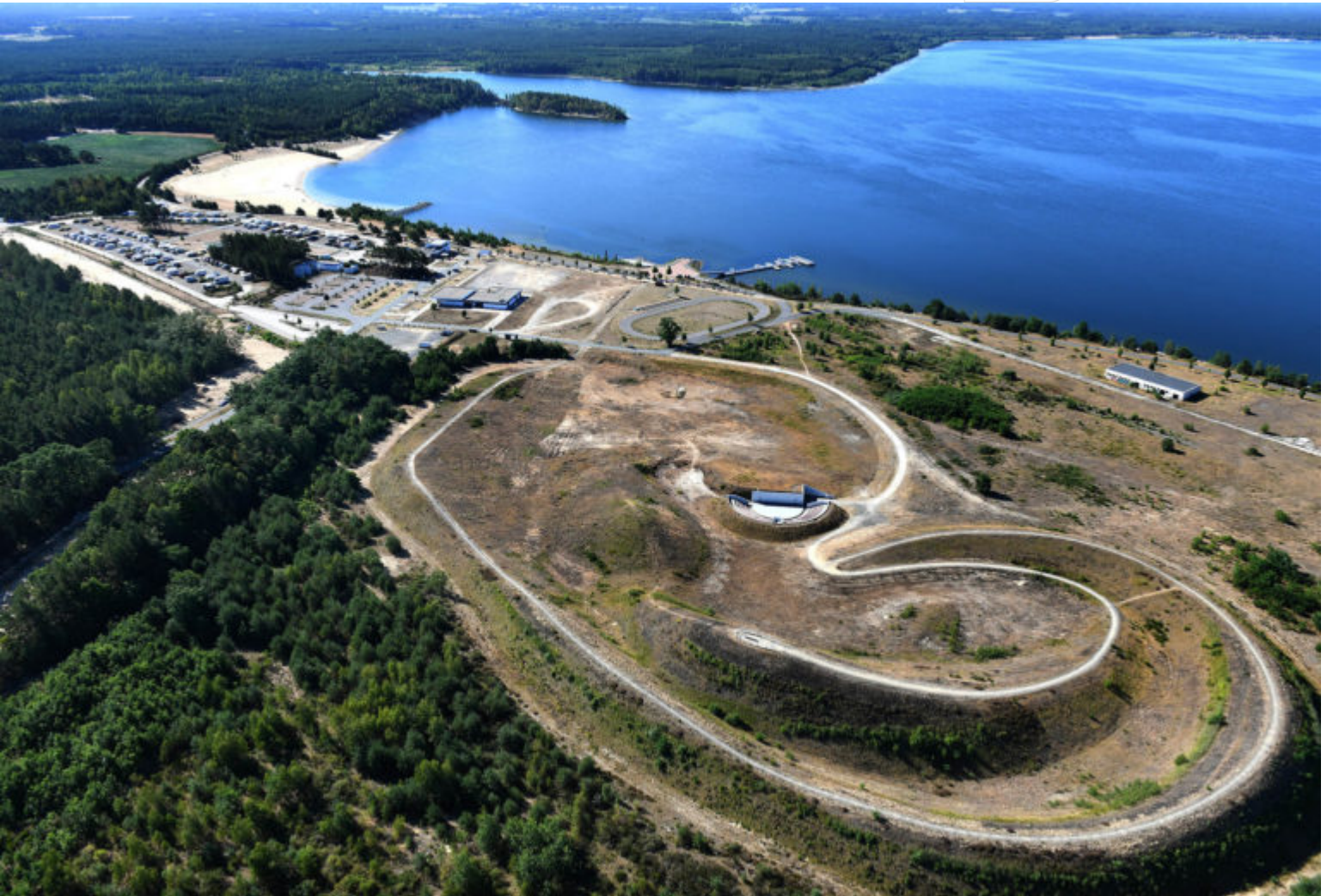
Landschaftsbauwerk OHR am See
