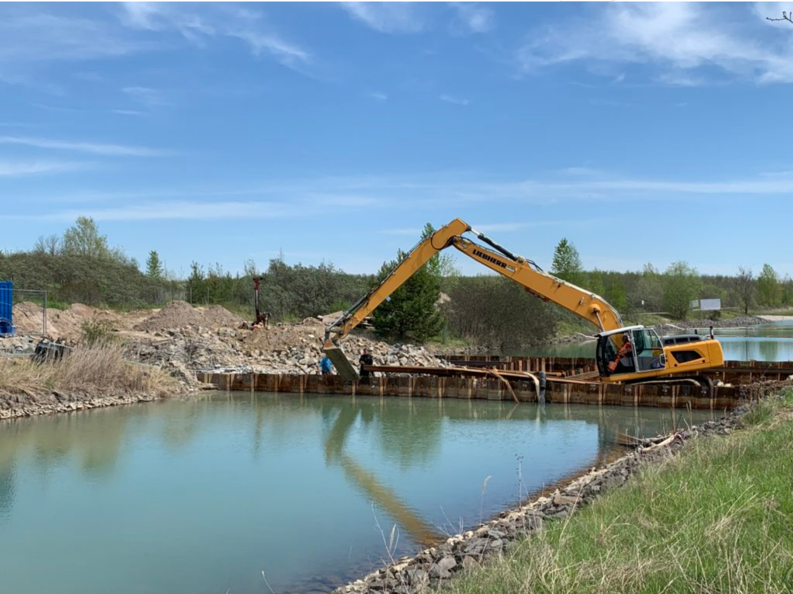
Auffüll- und Schweißarbeiten am Oberen Querbauwerk
