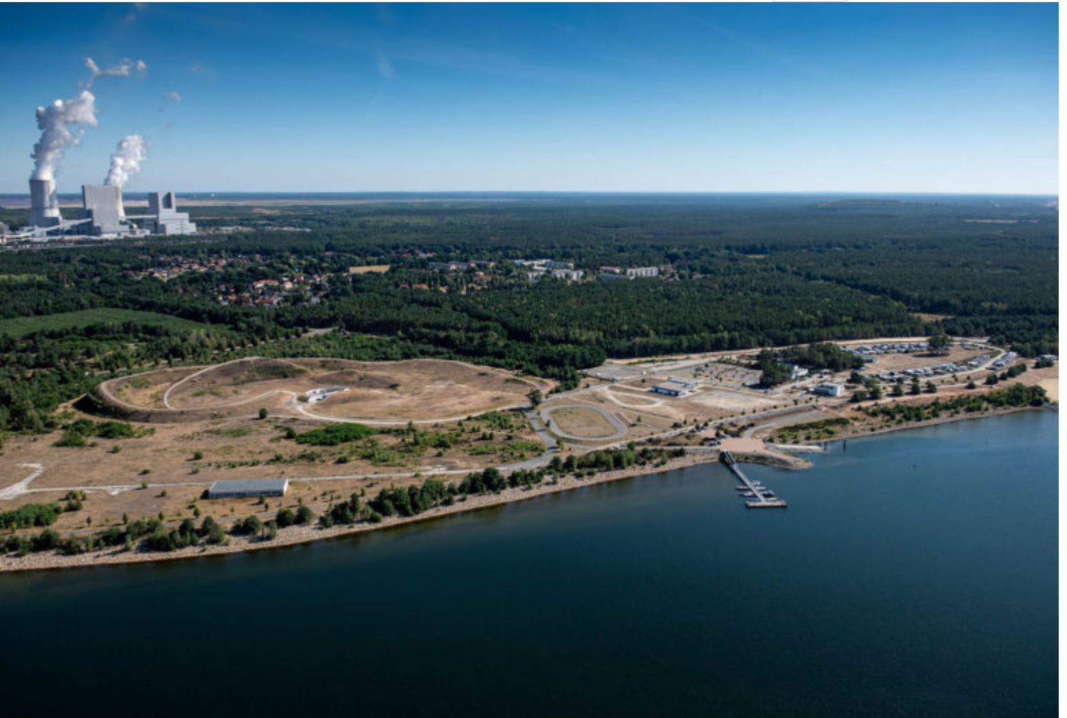
Boxberger Steganlage am Bärwalder See
