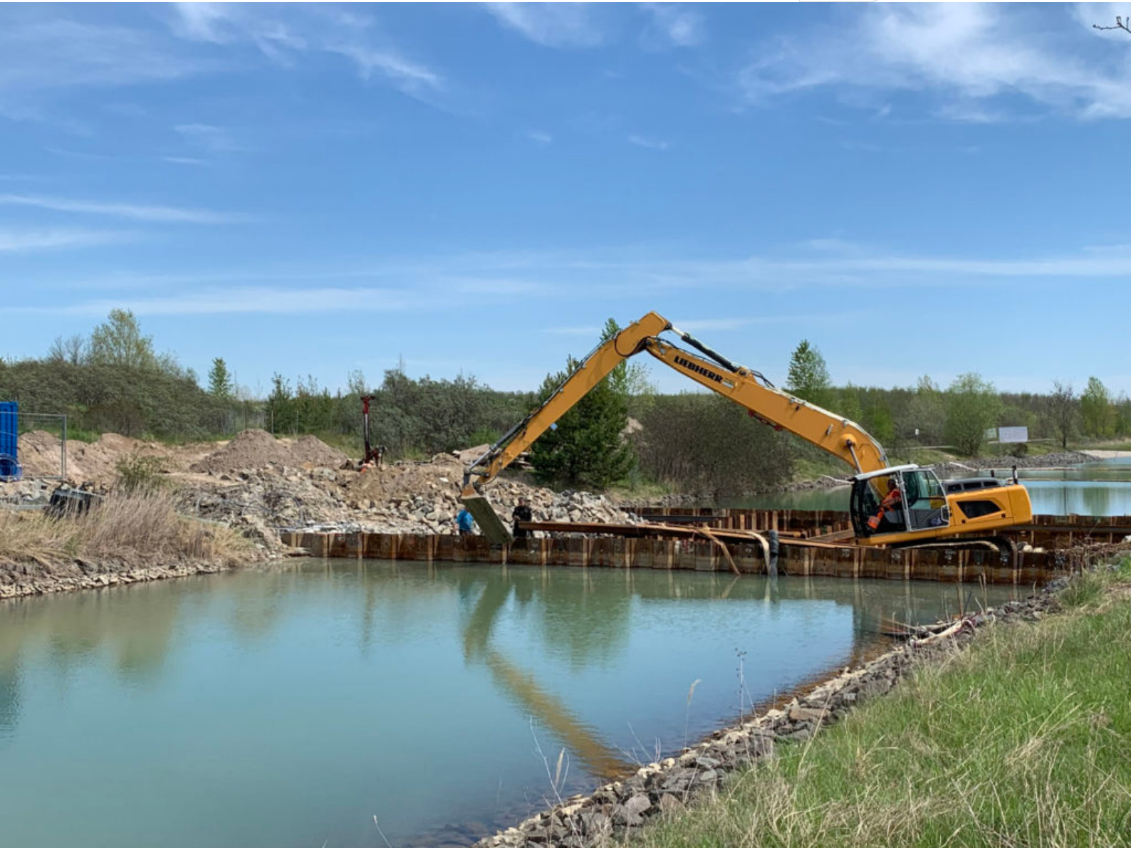
Auffüll- und Schweißarbeiten am Oberen Querbauwerk
