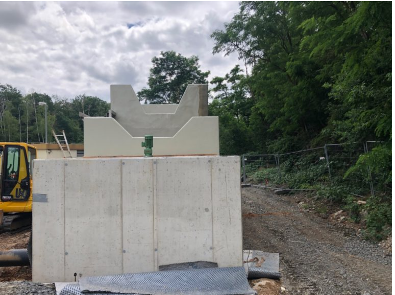
Drei-Kammer-Becken im Bau
