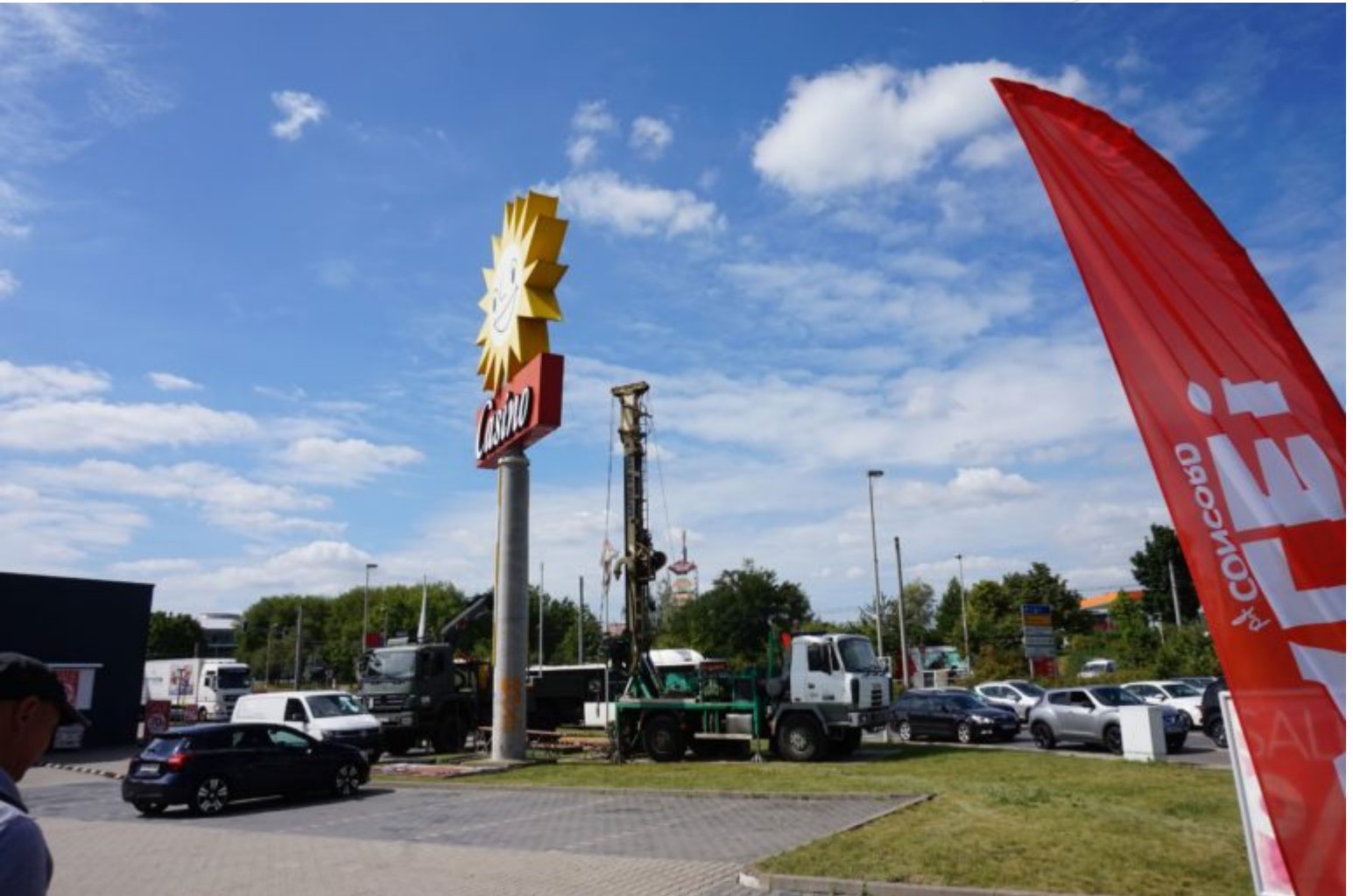
Bohrerkundungsprogramm im Abstrom der Grundwassereinigungsanlage Schedewitz
