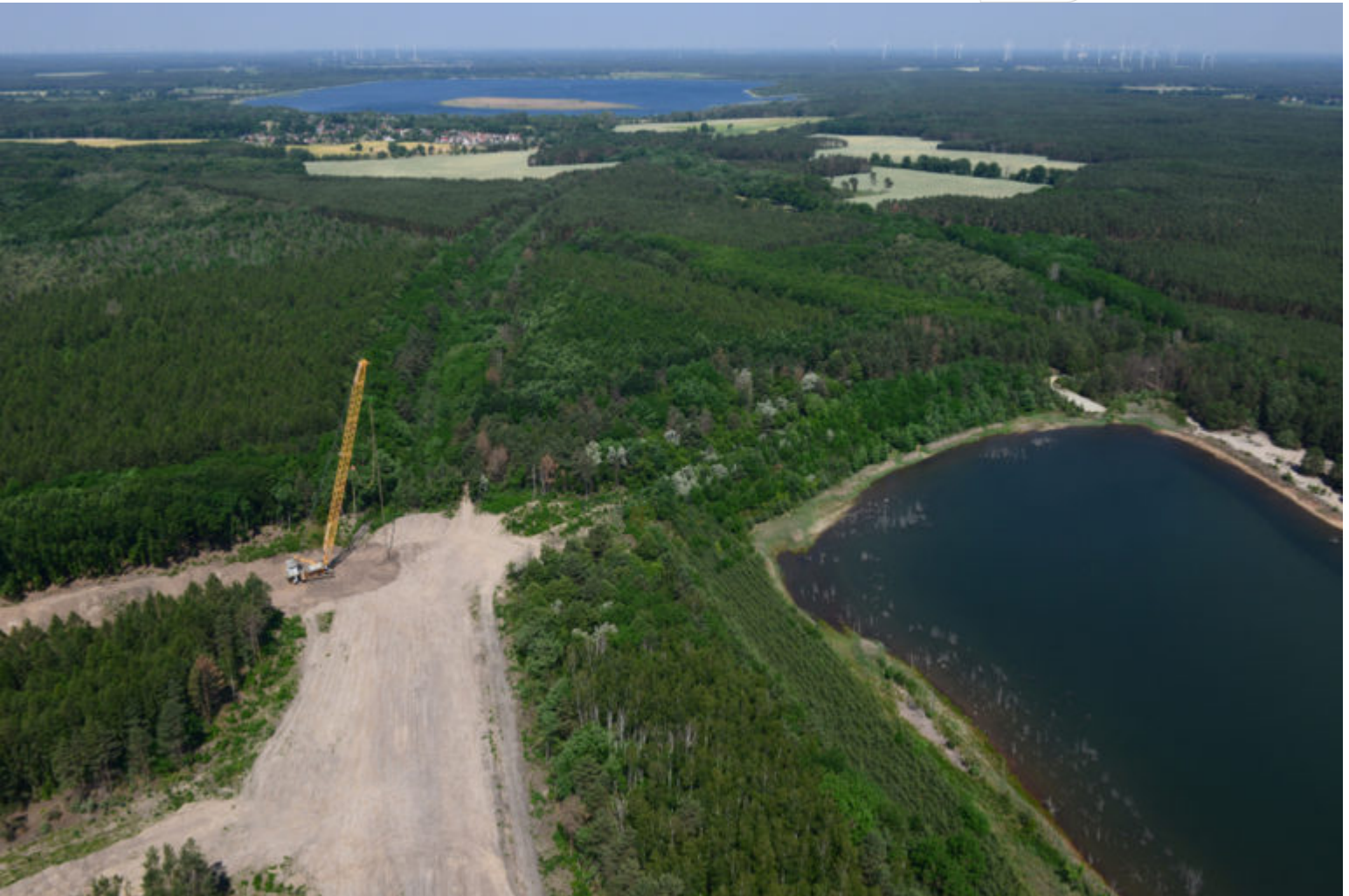
Rütteldruckverdichtung Kippe 10
