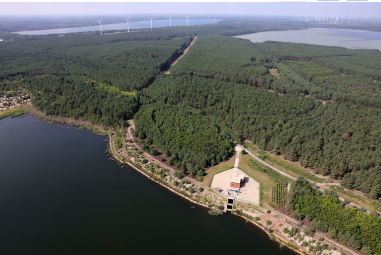
Einlaufbauwerk im SB Lohsa II
