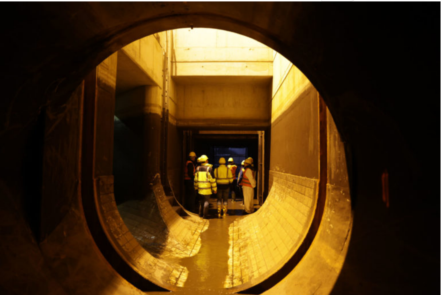
LMBV Überleiter Speicherbecken Lohsa II
