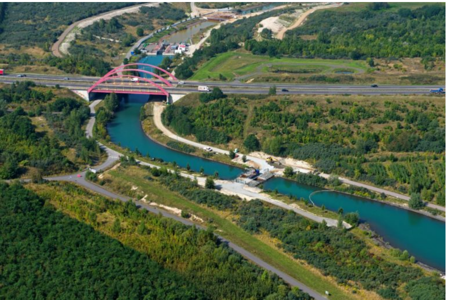
Störmthaler Kanal mit Sicherungsbauwerken aus südöstlicher Richtung im September 2021 (Foto: LMBV / Christian Bedeschinski)
