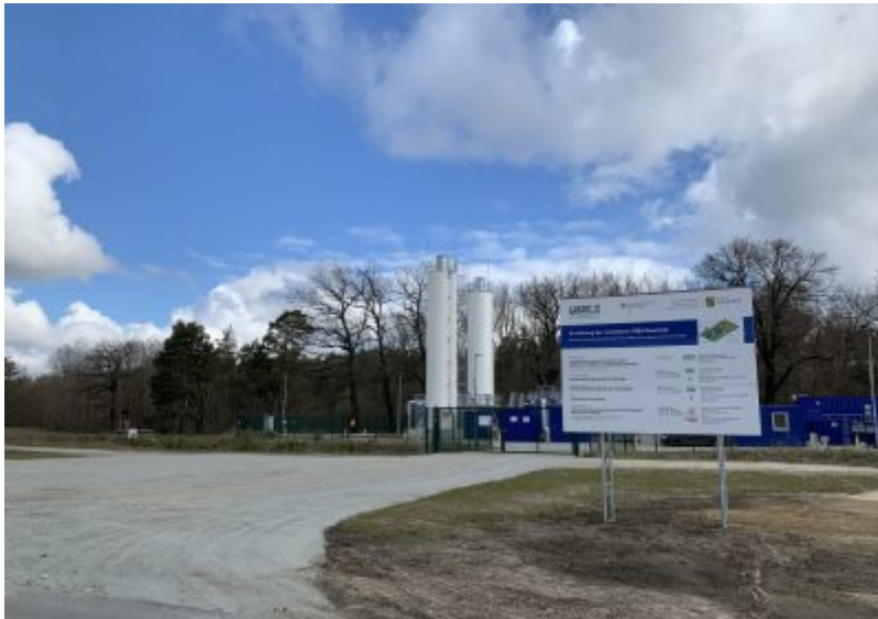
LMBV-Anlage bei Neustadt an der Spree
