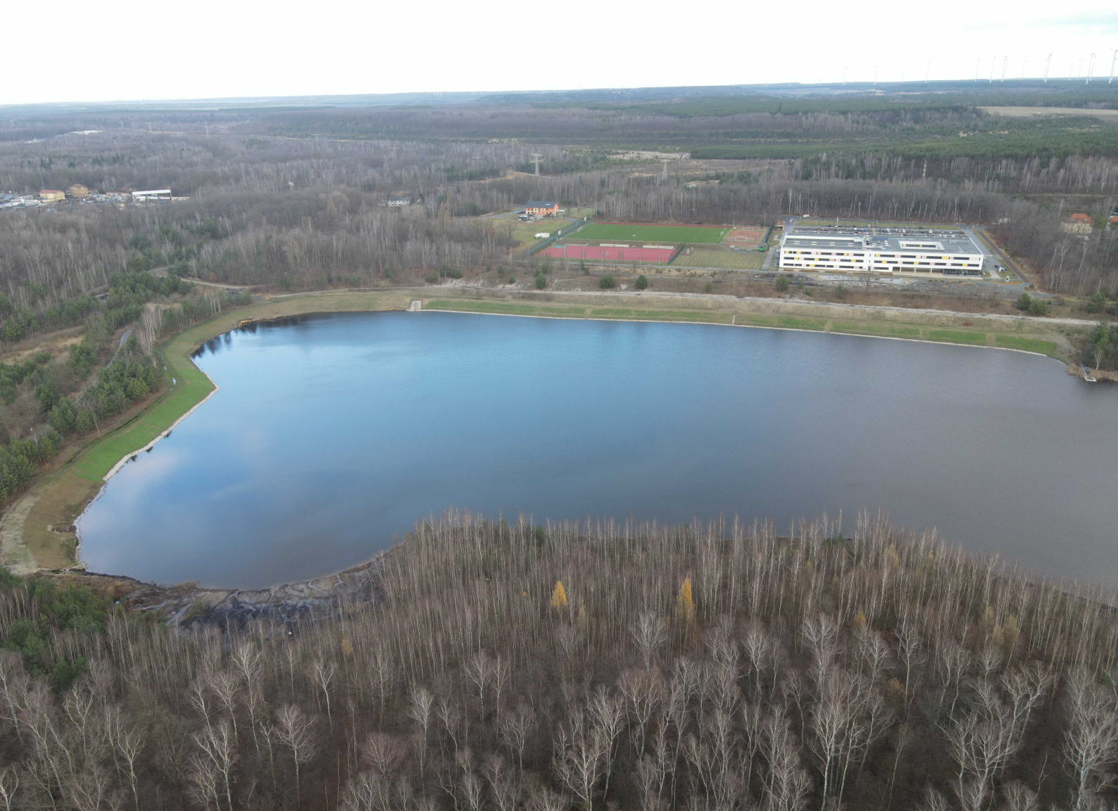
Kohleschlammfläche im Restloch 29 nach der Maßnahme
