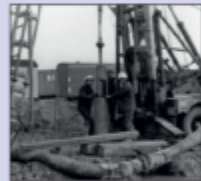
Errichtung der Förderbandanlage, 1976
