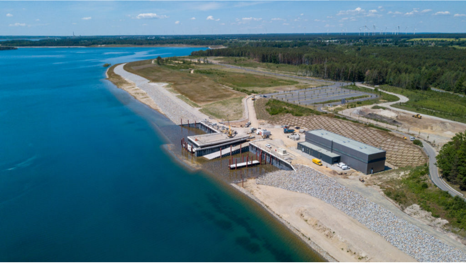
Sanierungsstützpunkt am Sedlitzer See
