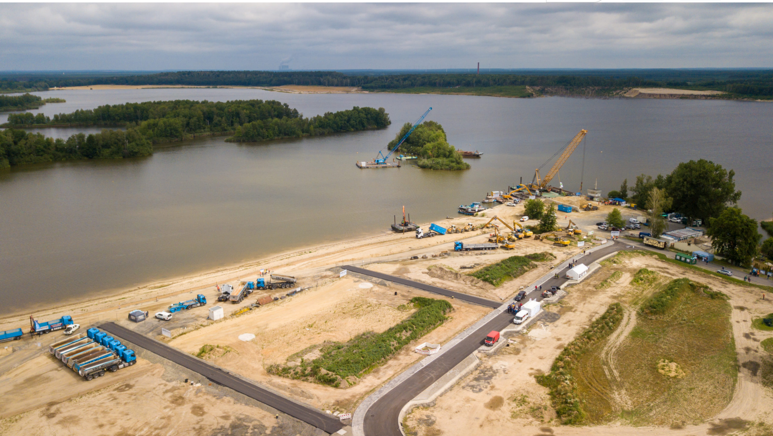
Baustelleninformationstag am Knappensee 2022
