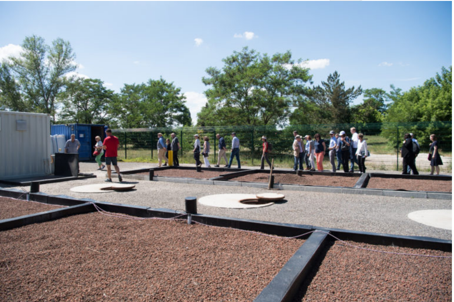
Besichtigung der wetlandbasierten Anlage.
