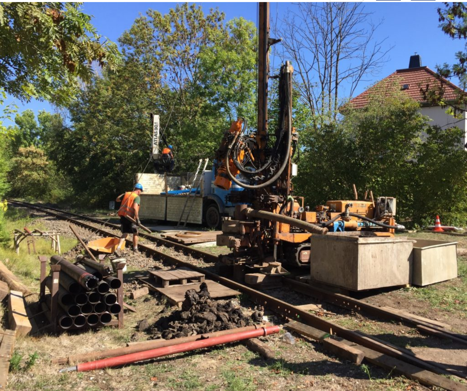
Erkundungsbohrungen Kohletraditionsbahn Meuselwitz (2018/2019)
