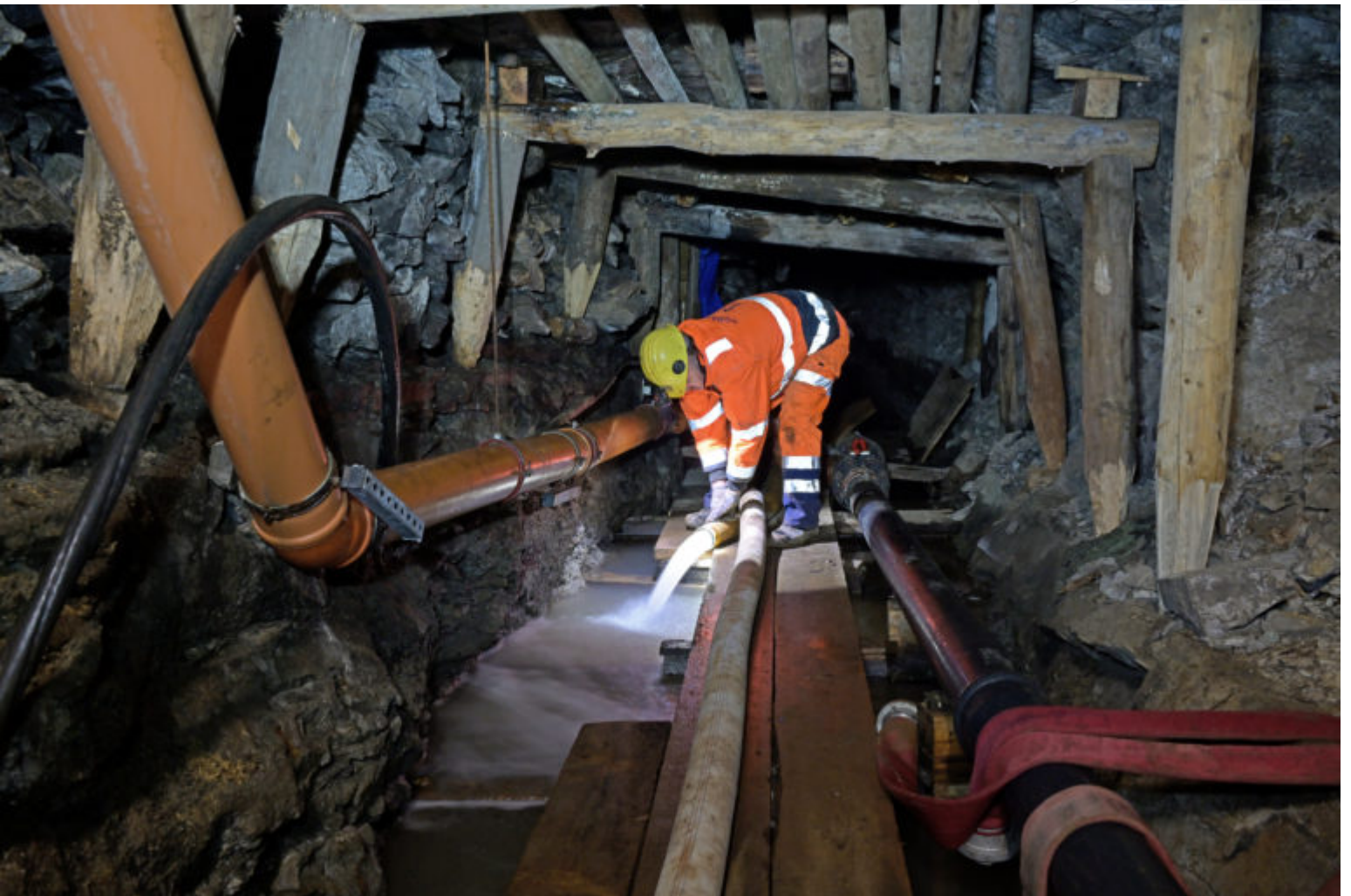
Ableitung des Wassers in Segen-Gottes-Stollen.
