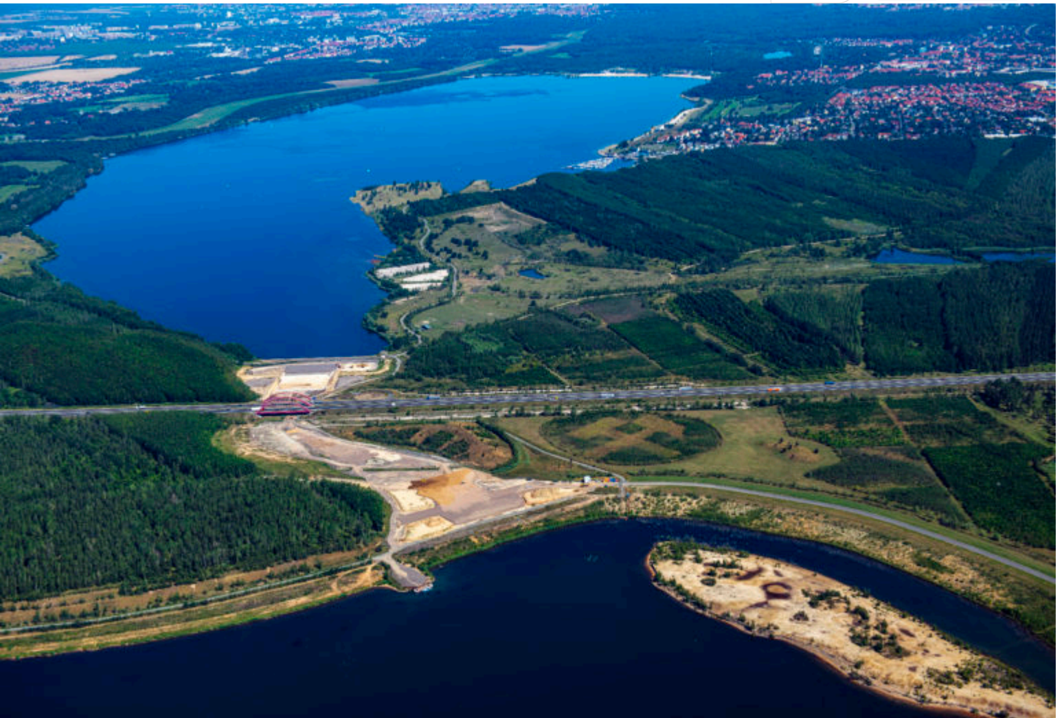
Ruhende Baustelle Harthkanal – Archivfoto v. P. Radke
