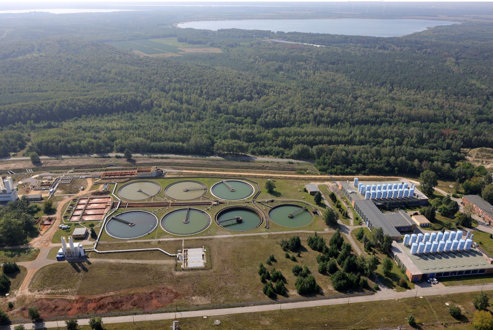
Grubenwasserreinigungsanlage Schwarze Pumpe
