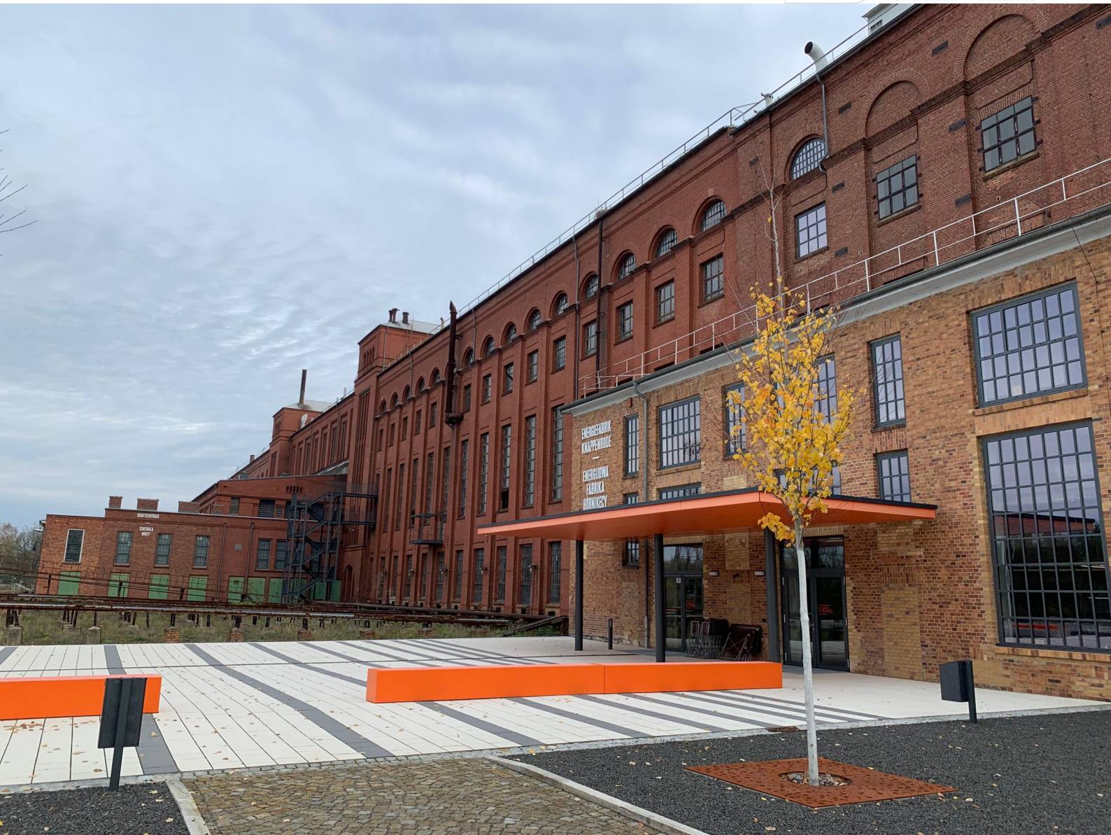
Eingangsbereich der Energiefabrik Knappenrode im November 2022
