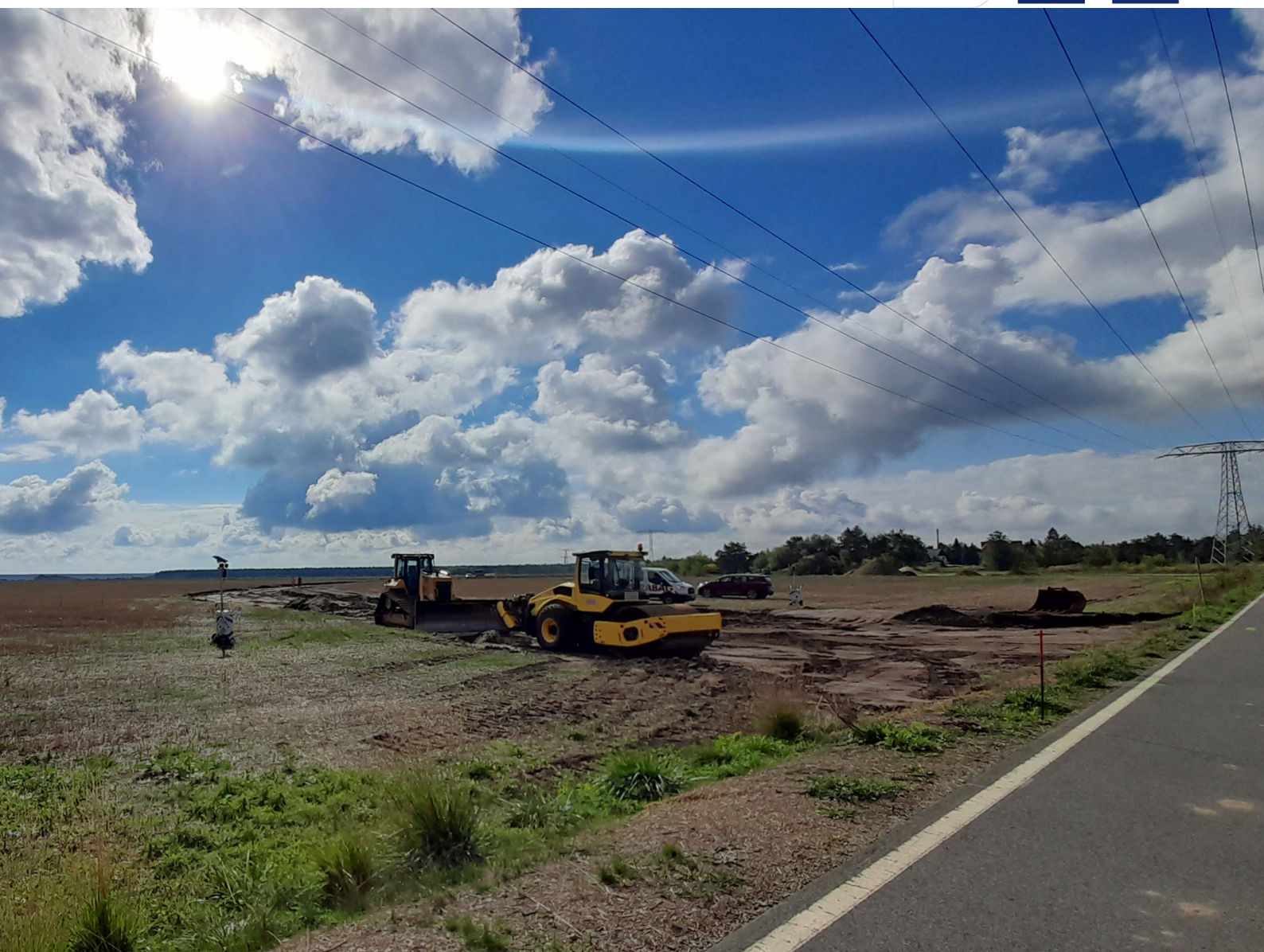
Bauzufahrt zur Brückensfeldkippe Sedlitz, Sep. 2022
