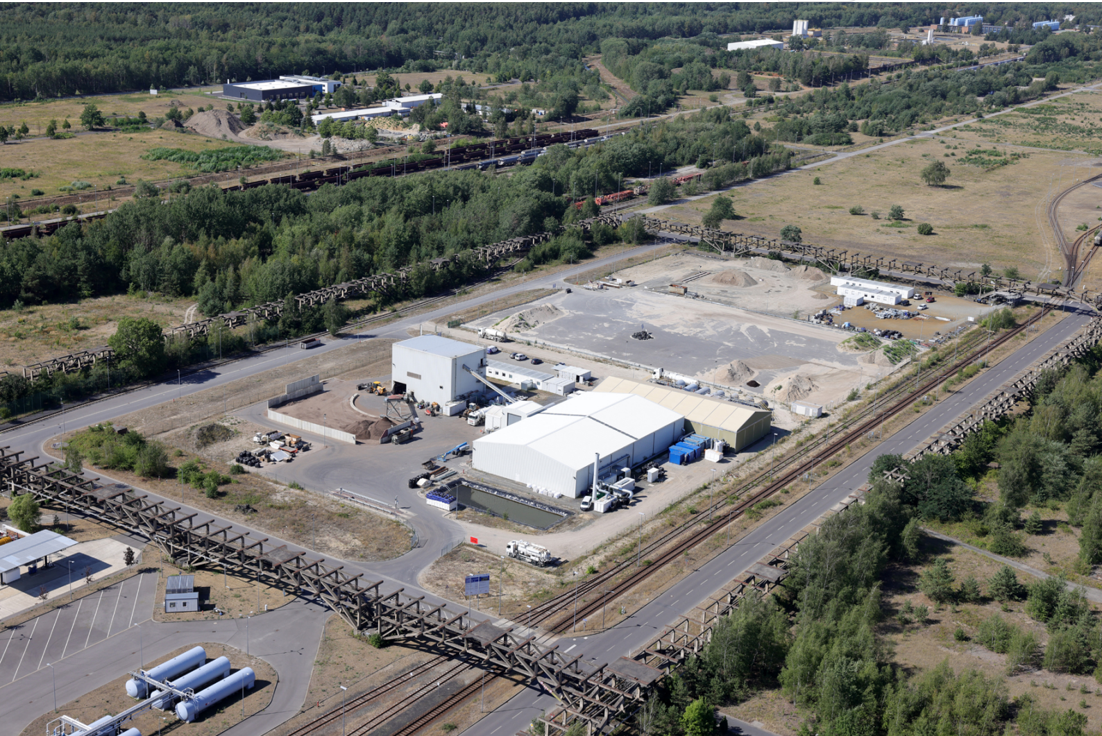
Blick auf die Vakuumenthermische Reinigungsanlage (VTRA)
