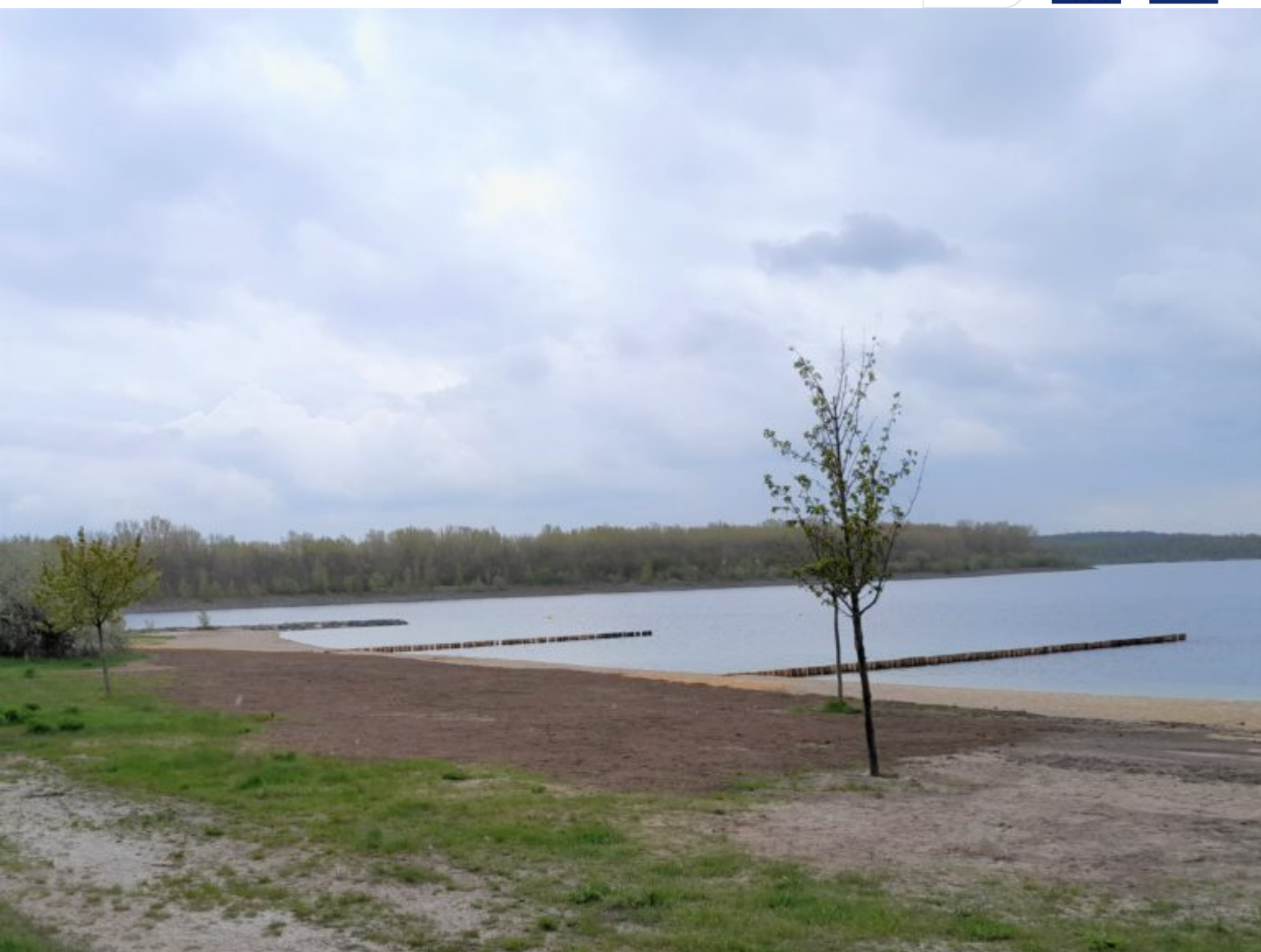
Blick in Richtung Auslaufbauwerk
