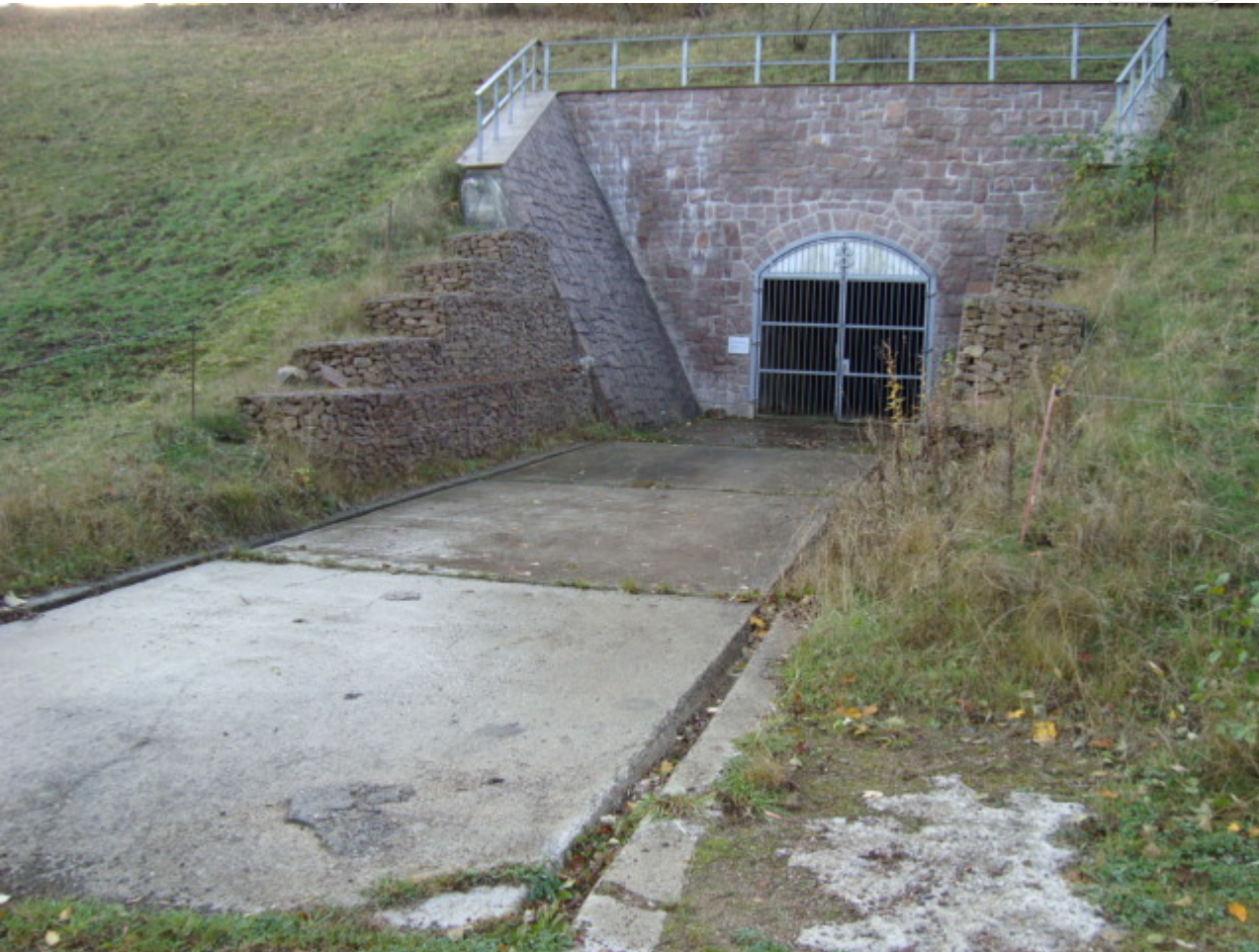
Mundloch Entwässerungsstollen Altenberg
