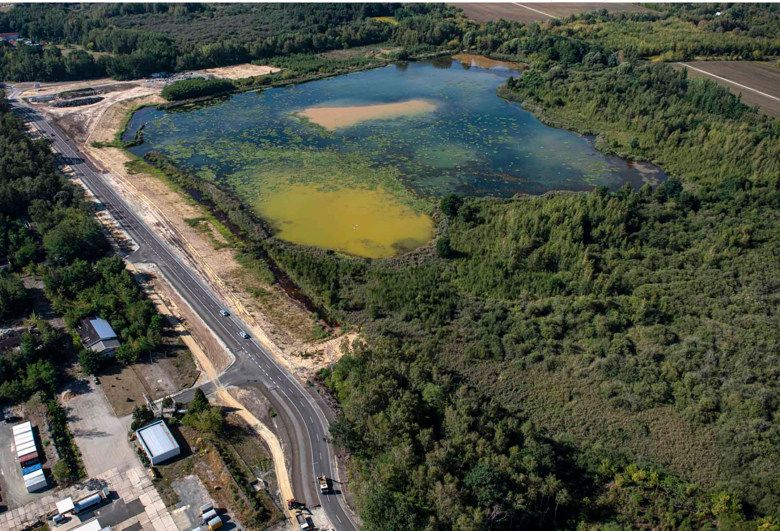
Ortrander Str. in Lauchhammer – 2019 während der Sanierungsarbeiten
