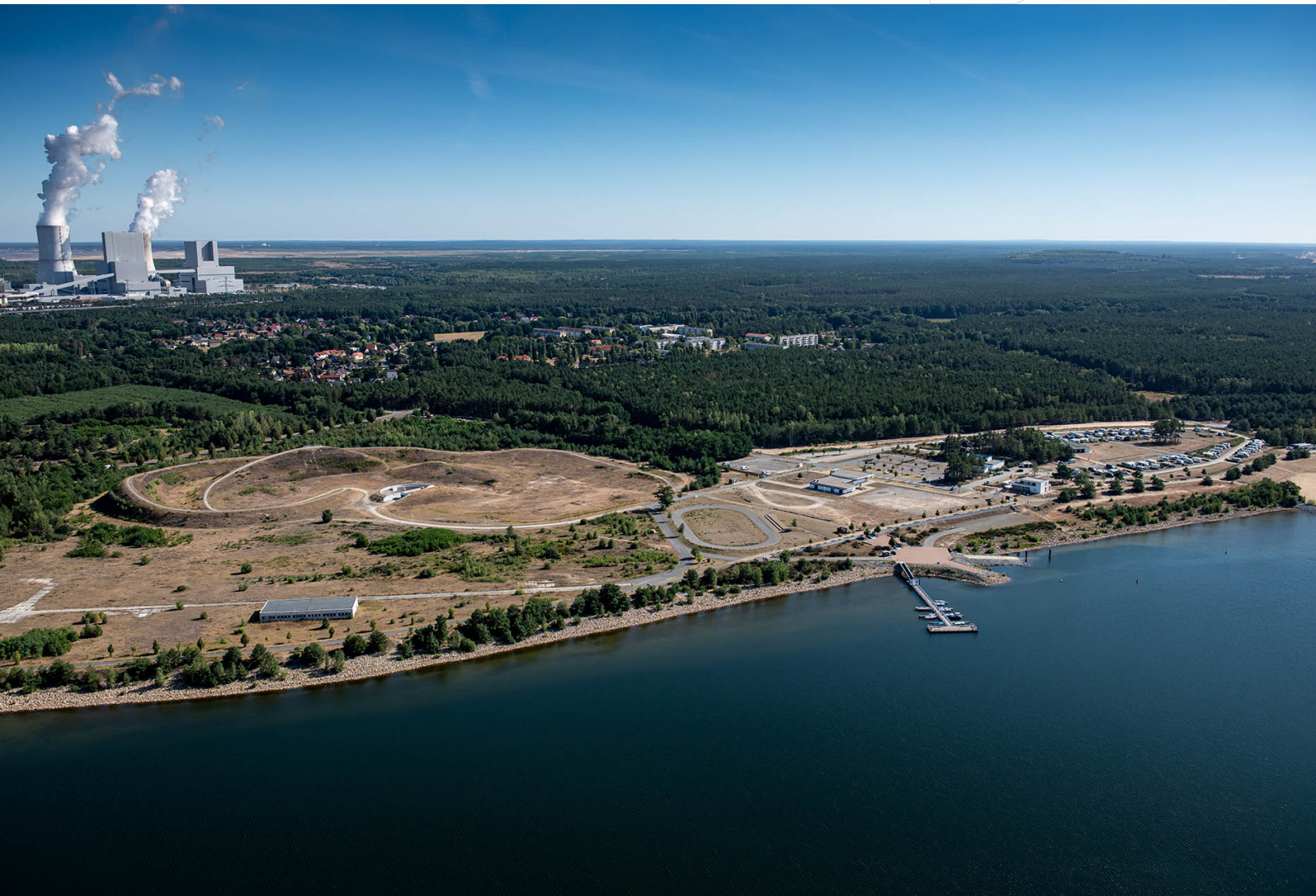
Boxberger Steganlage am Bärwalder See
