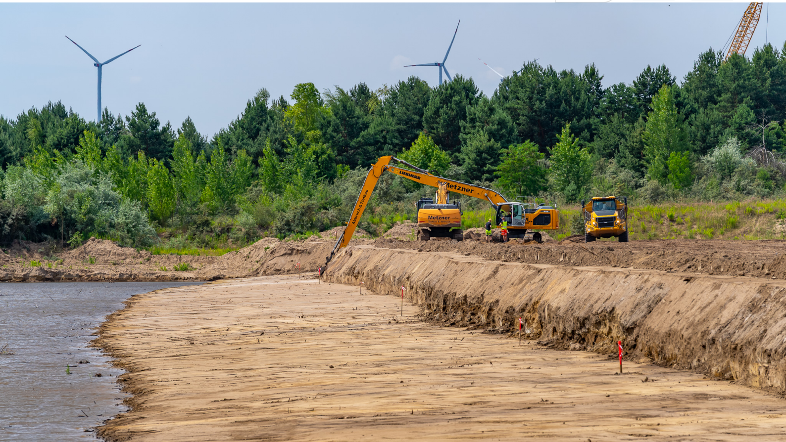
Sanierungsarbeiten am Restloch Greifenhain (Juni 2025)
