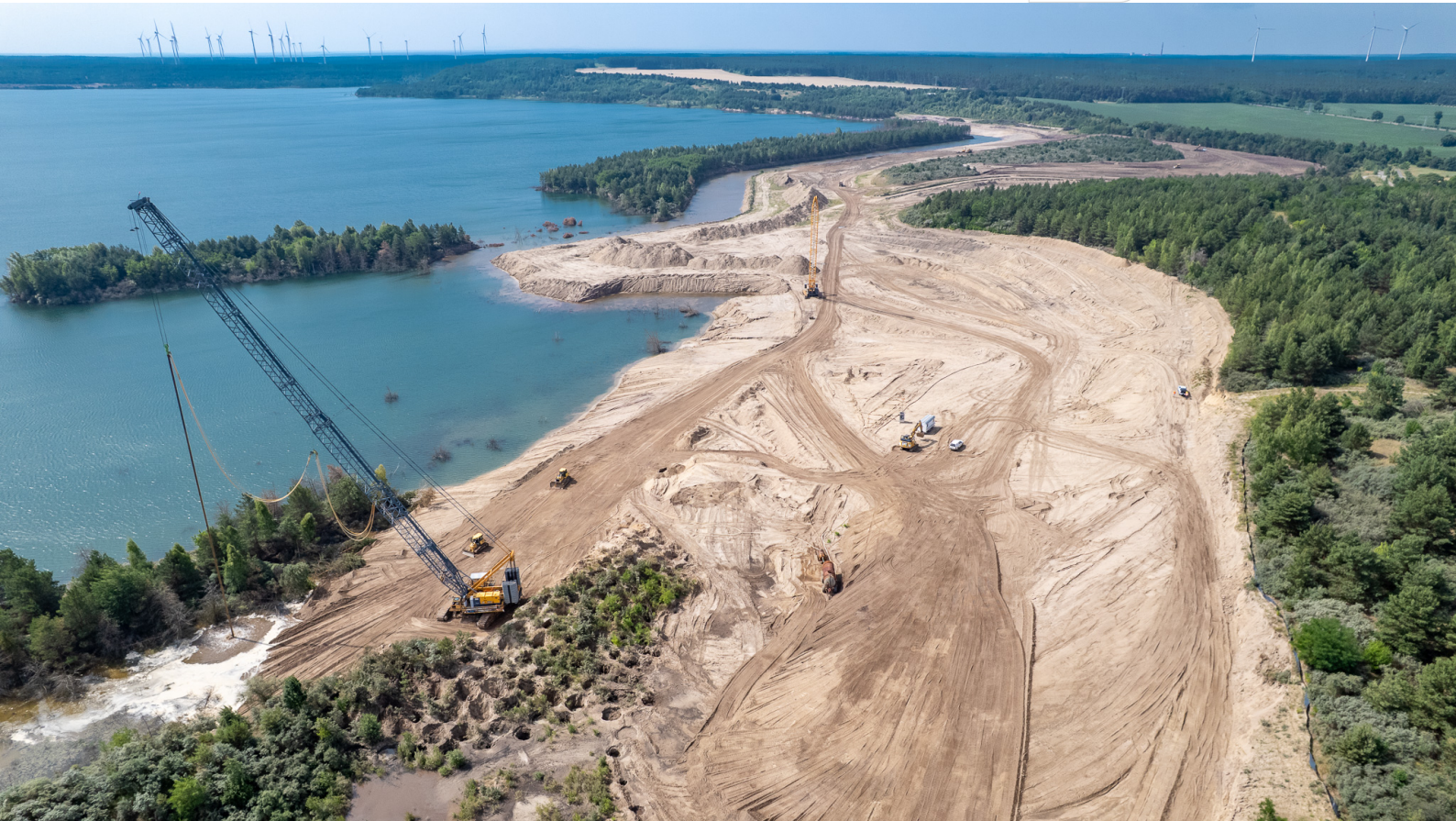
Sanierungsarbeiten am Restloch Greifenhain (Juni 2025)
