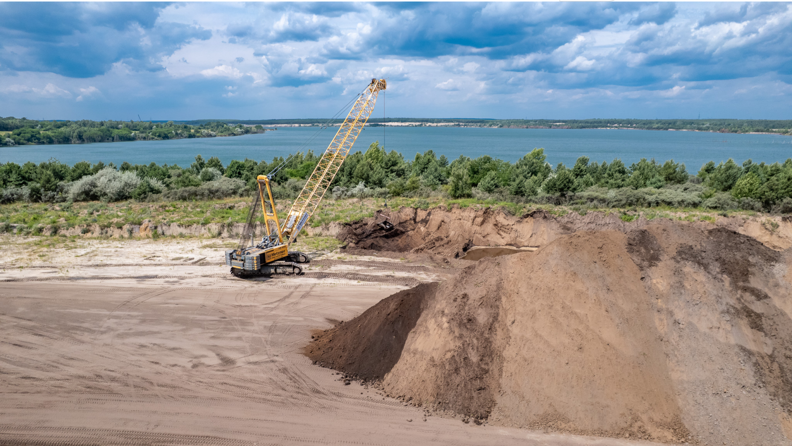
Sanierungsarbeiten am Restloch Greifenhain (Juni 2025)
