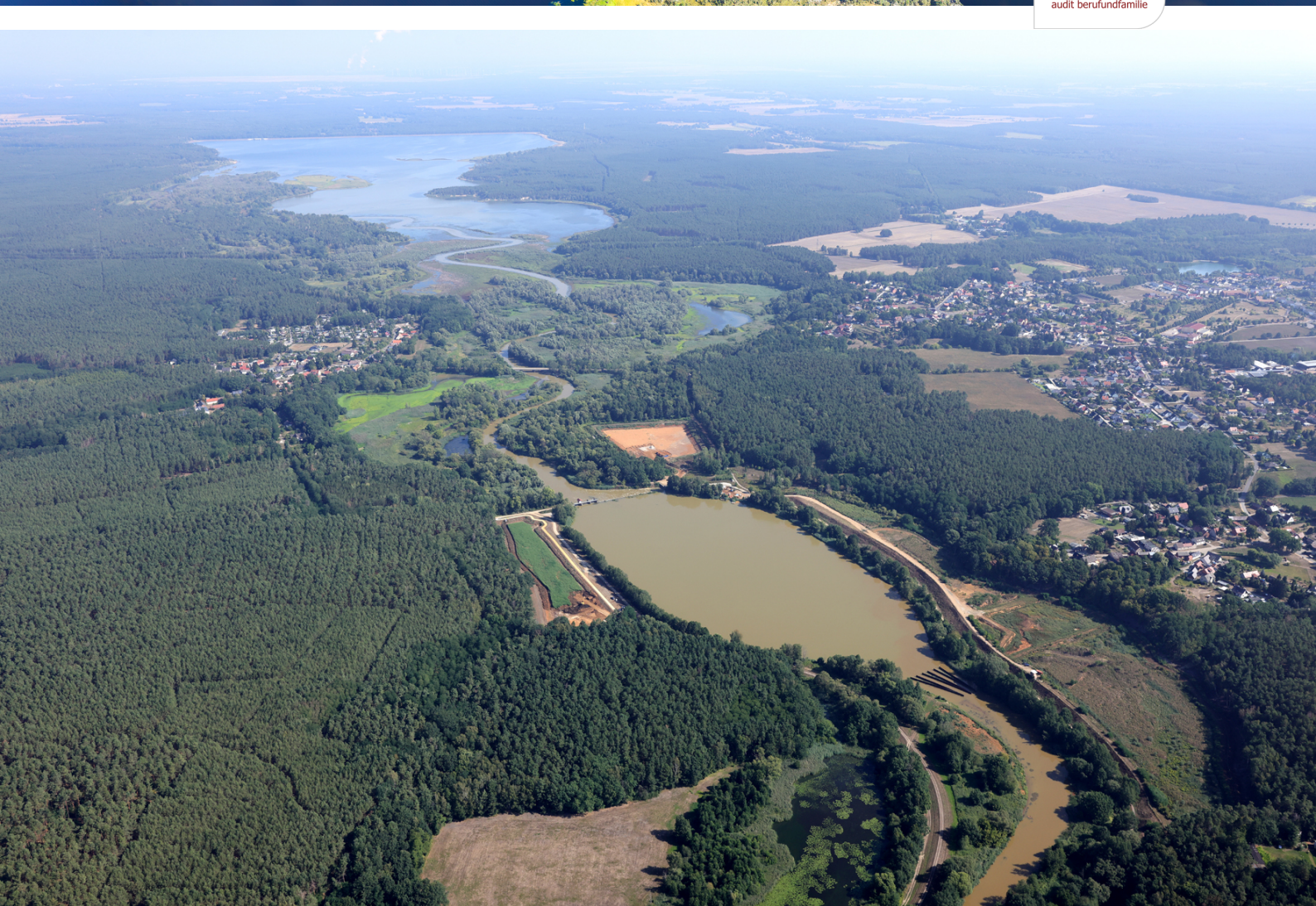
Blick auf die Talsperre Spremberg
