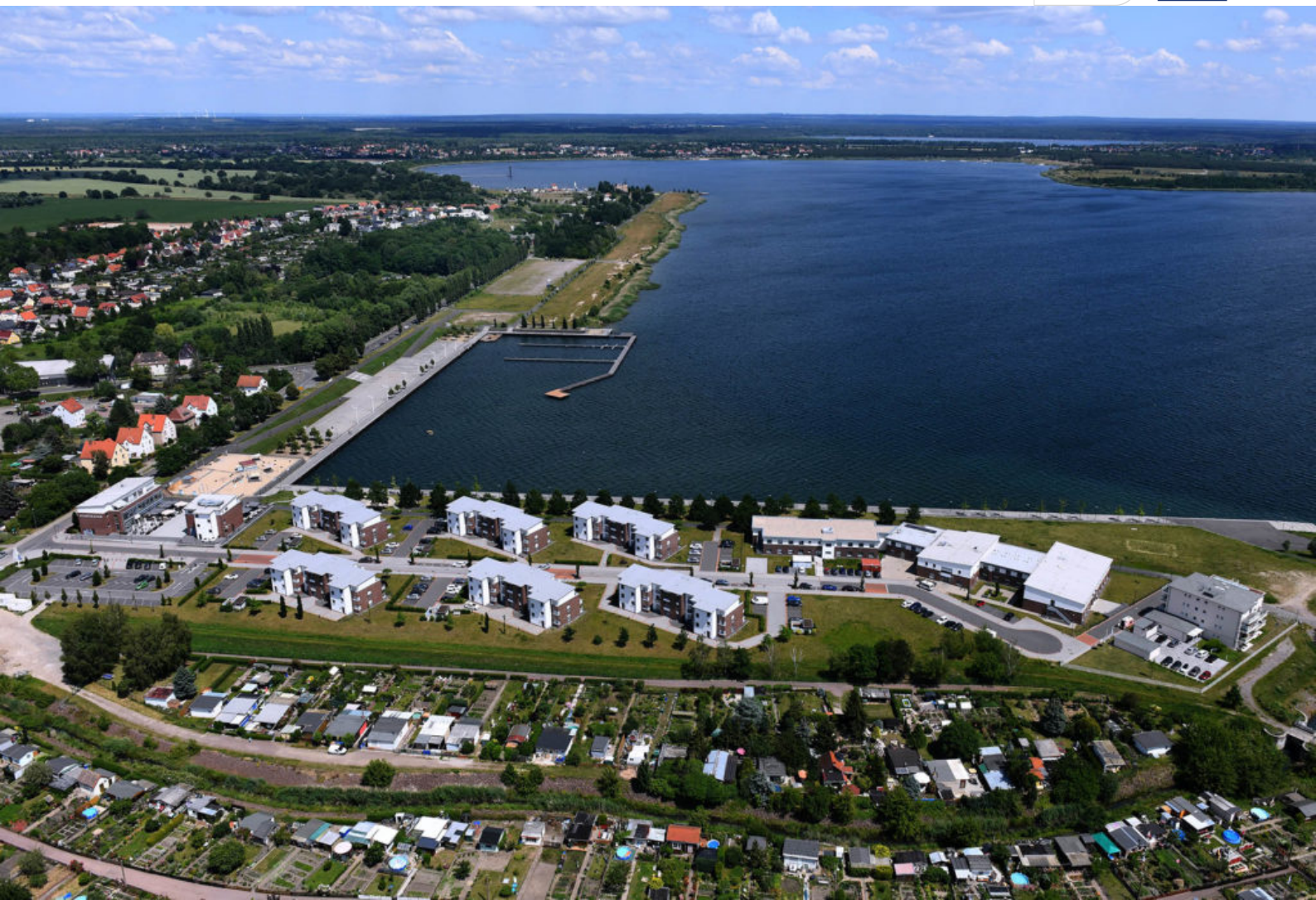
Wohnbebauung an der Goitzsche
