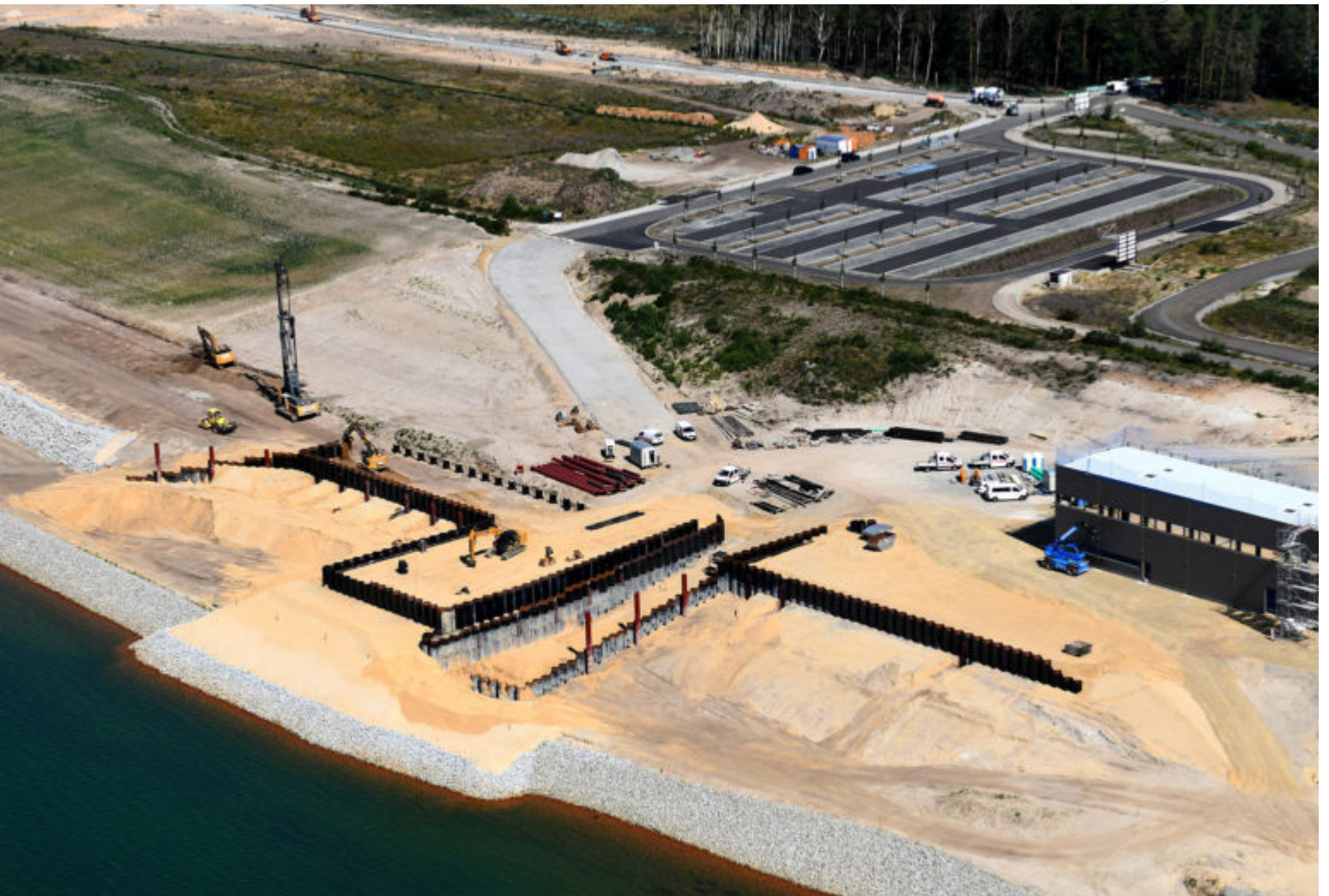
Sanierungsstützpunkt im Bau
