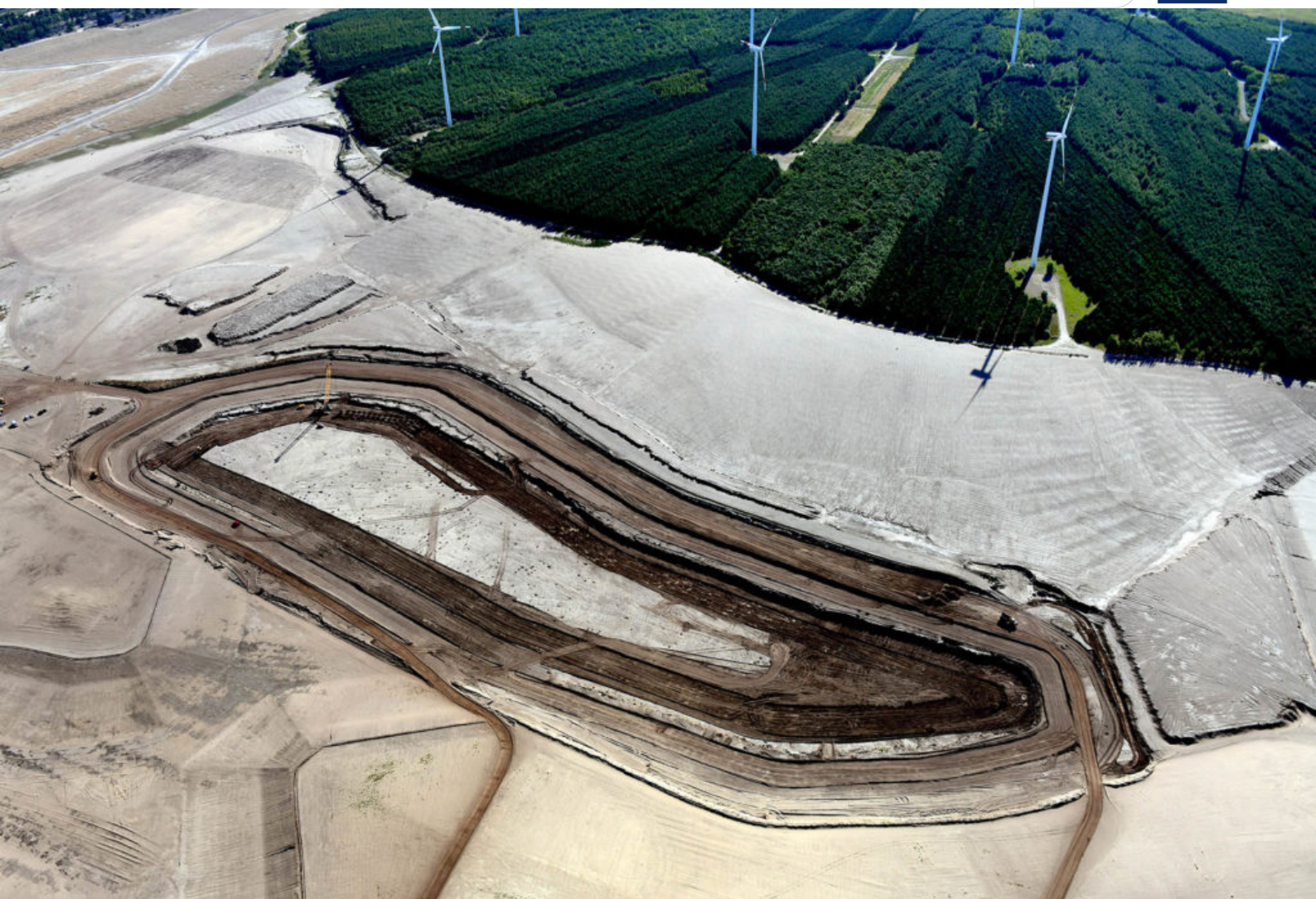
Verichtung der Inselufer im künftigen Cottbuser Ostsee
