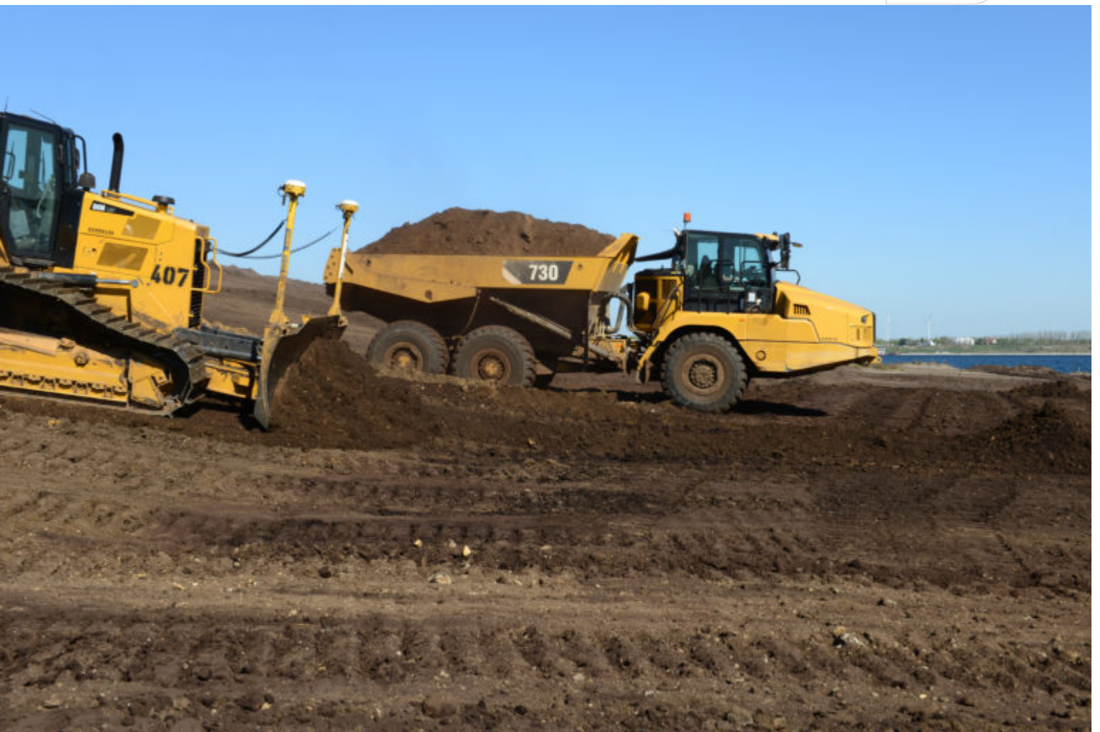
Böschungsgestalten am Großräschener Seeufer i.A. der LMBV
