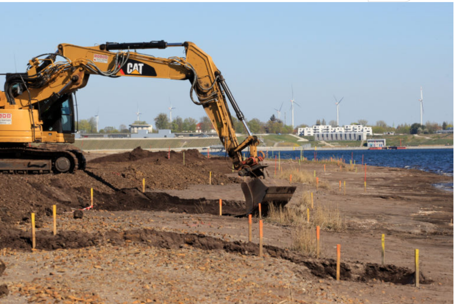
Böschungsgestaltung an Westufer des Restloches vom Tagebau Meuro
