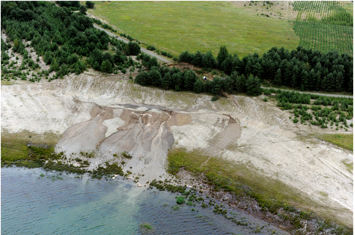
Rutschung am Speicherbecken Lohsa II (2012)
