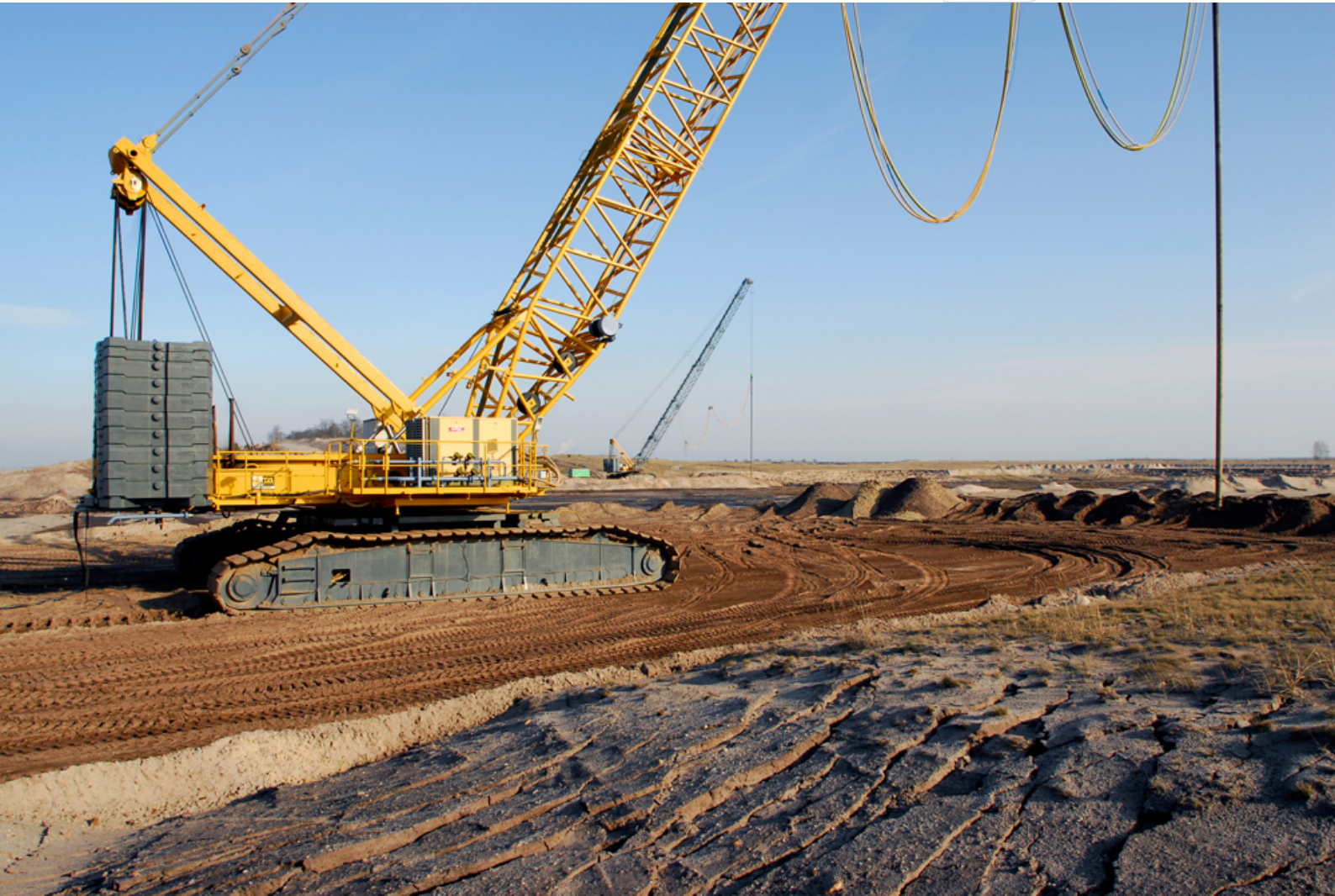
Einsatz von Rütteldruckverdichtung in der Lausitz (2012)
