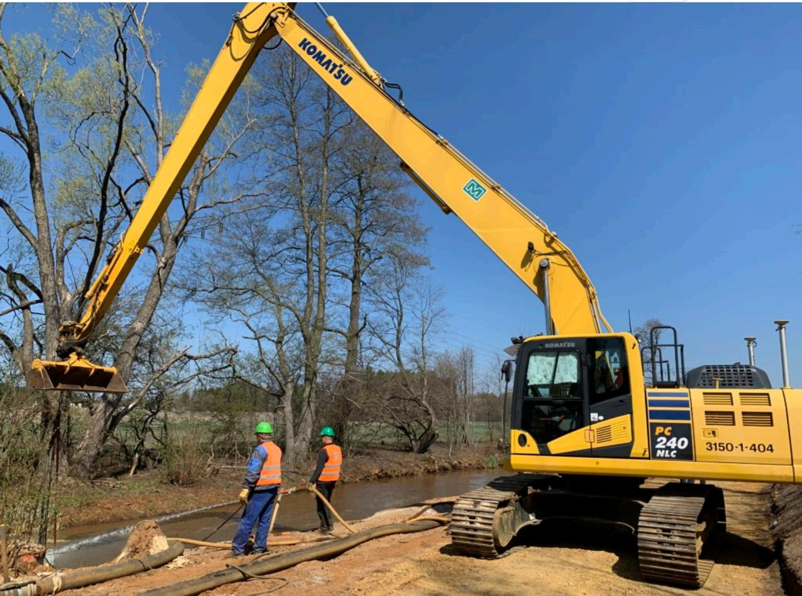
Zunächst laufen derzeit nach Herstellen einer Baustraße sowie von Entwässerungsplätzen im nördlichen Bauabschnitt III erste Entschlammungsarbeiten. Dabei wird mit einem Bagger mit angeschlossener Saugpumpe die teilweise EHS-belastete Kolmationsschicht ausgesaugt. Das Baggergut wird in große geotextile Geotubes eingeleitet und nach einem ca. vierwöchigen Trocknungsprozess fachgerecht beprobt und entsorgt.
