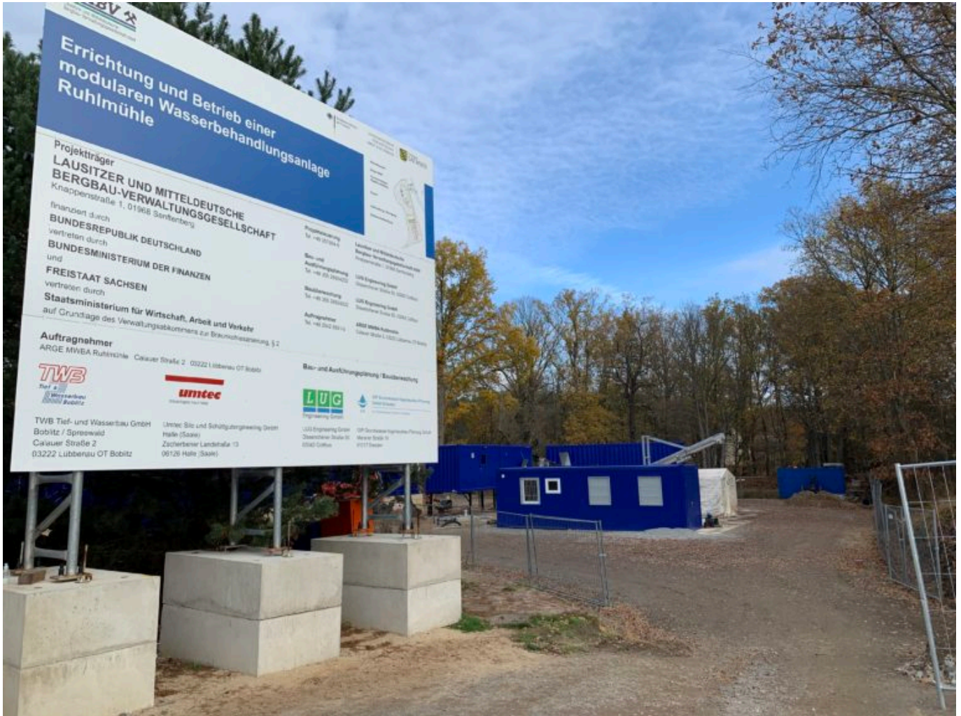
Baustellenschild für das Errichten der MWBA Ruhlmühle
