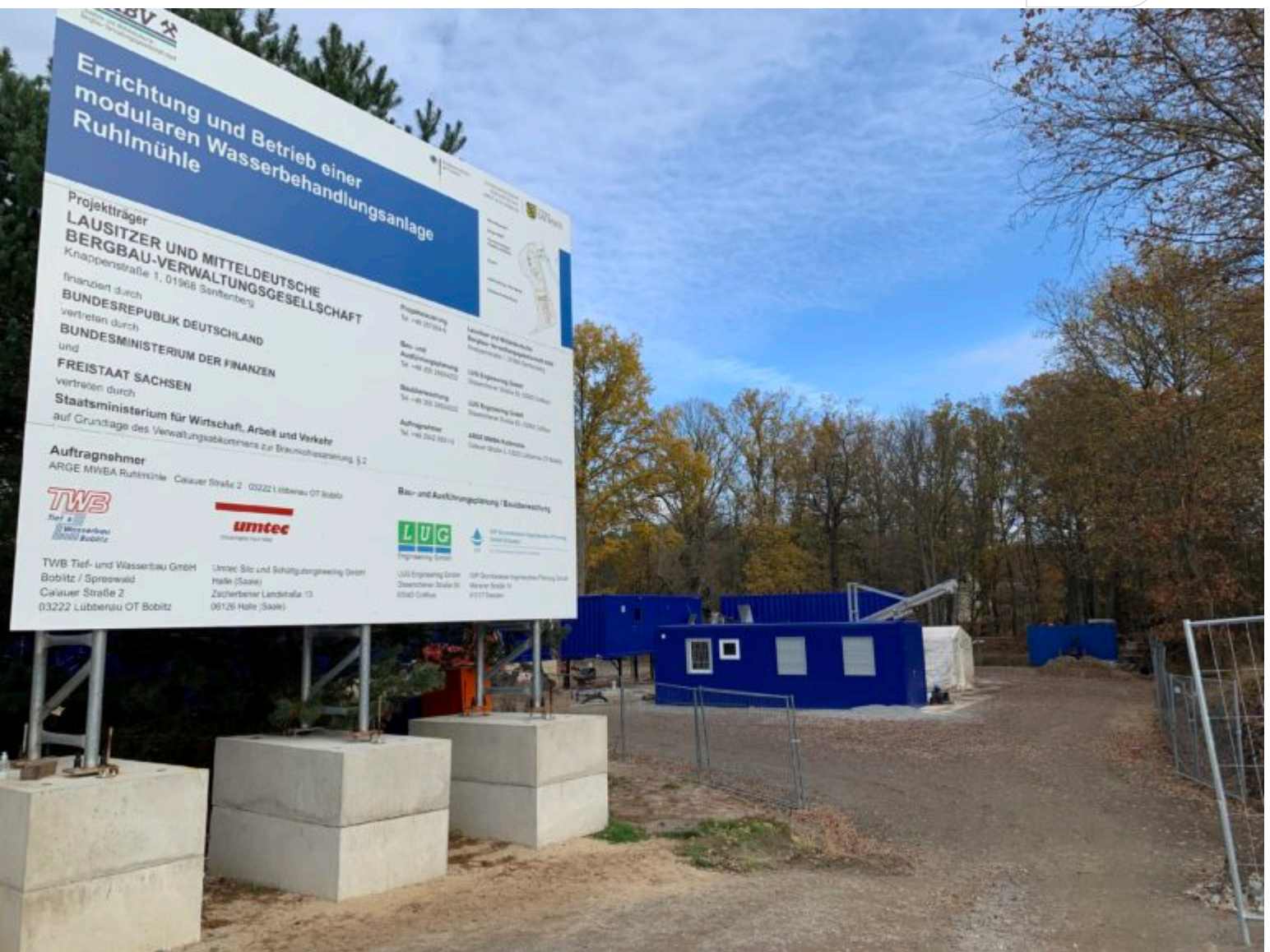
Baustellenschild für das Errichten der MWBA Ruhlmühle
