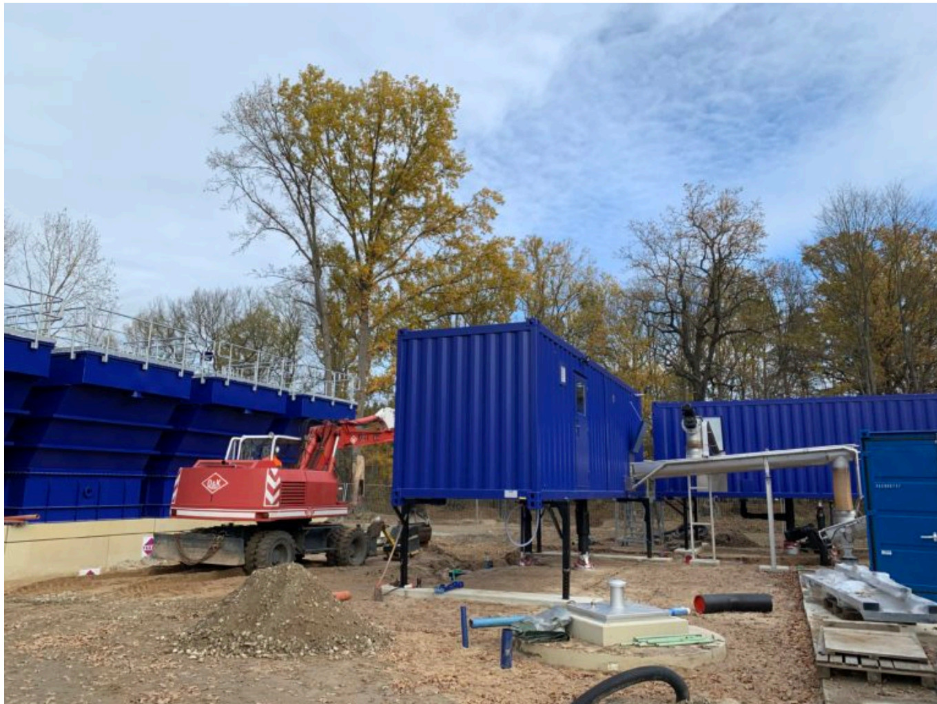
Modulare Bauweise | Ruhlmühl-Baustelle
