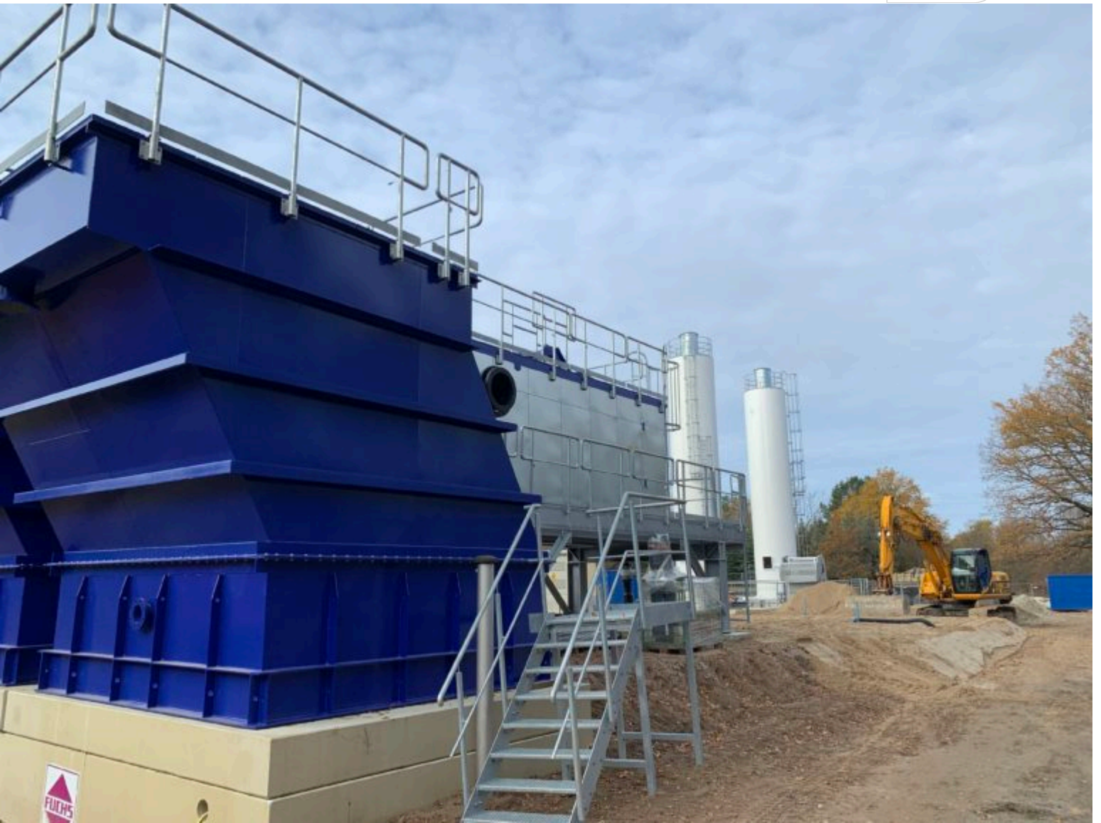
Sichtbarer Baufortschritt | MWBA Ruhlmühle
