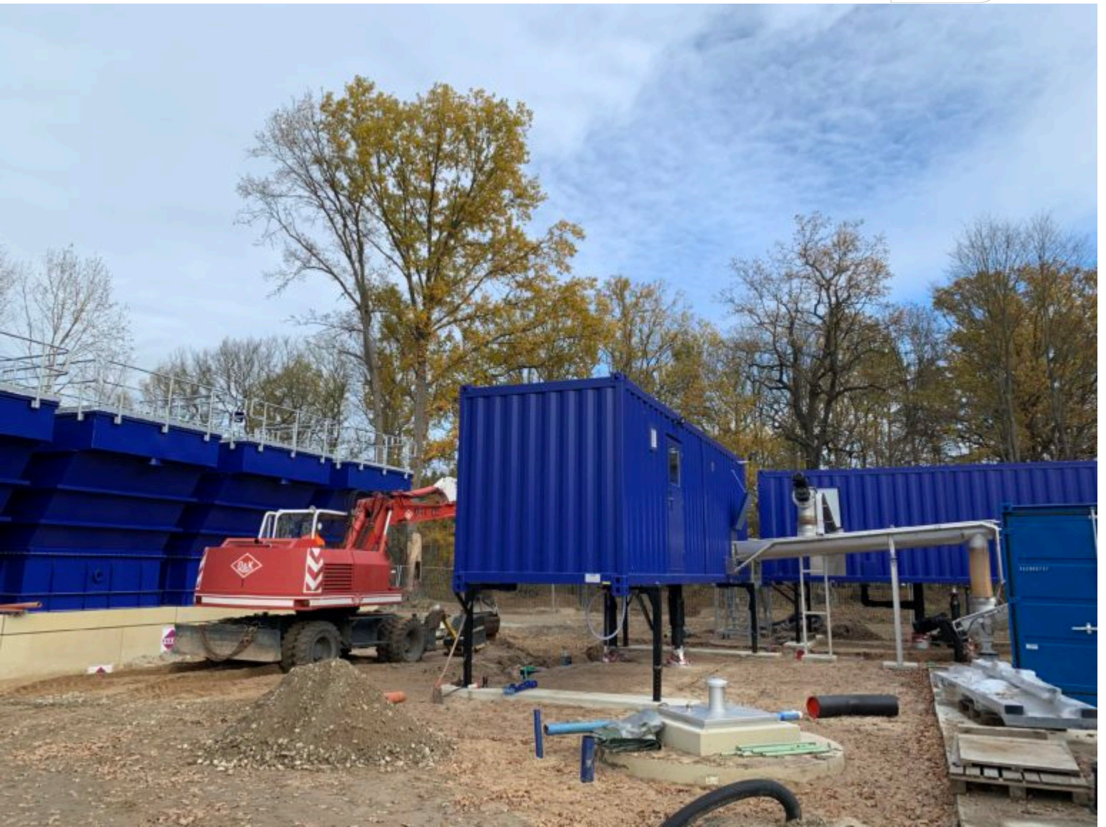
Modulare Bauweise | Ruhlmühl-Baustelle
