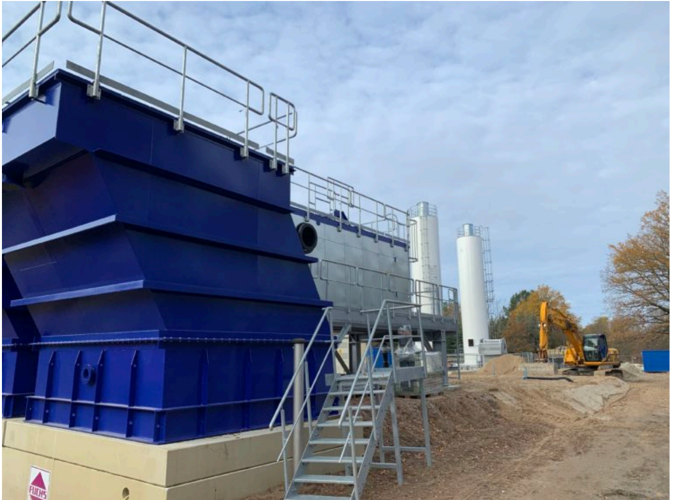
Sichtbarer Baufortschritt | MWBA Ruhlmühle
