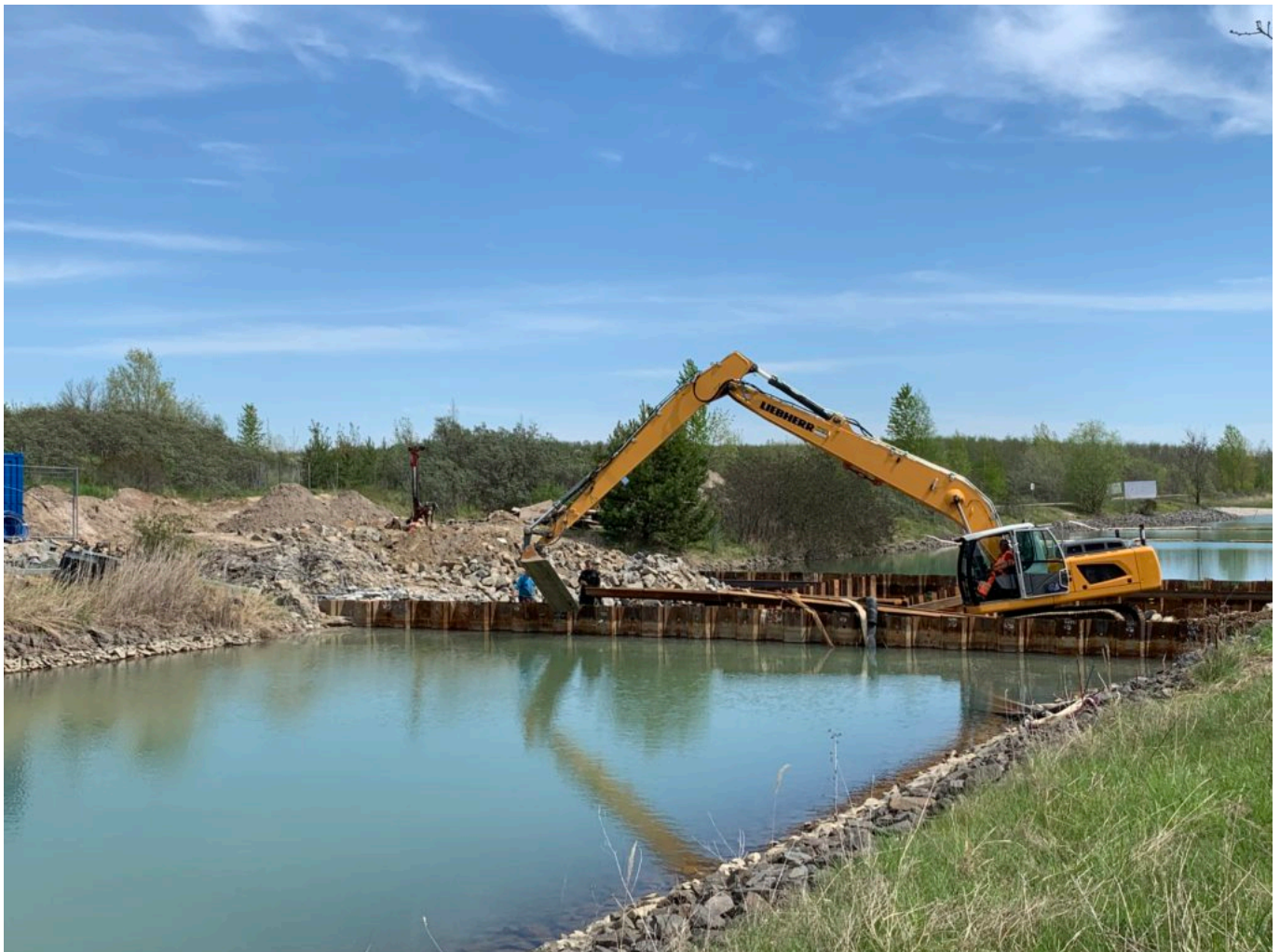
Auffüll- und Schweißarbeiten am Oberen Querbauwerk
