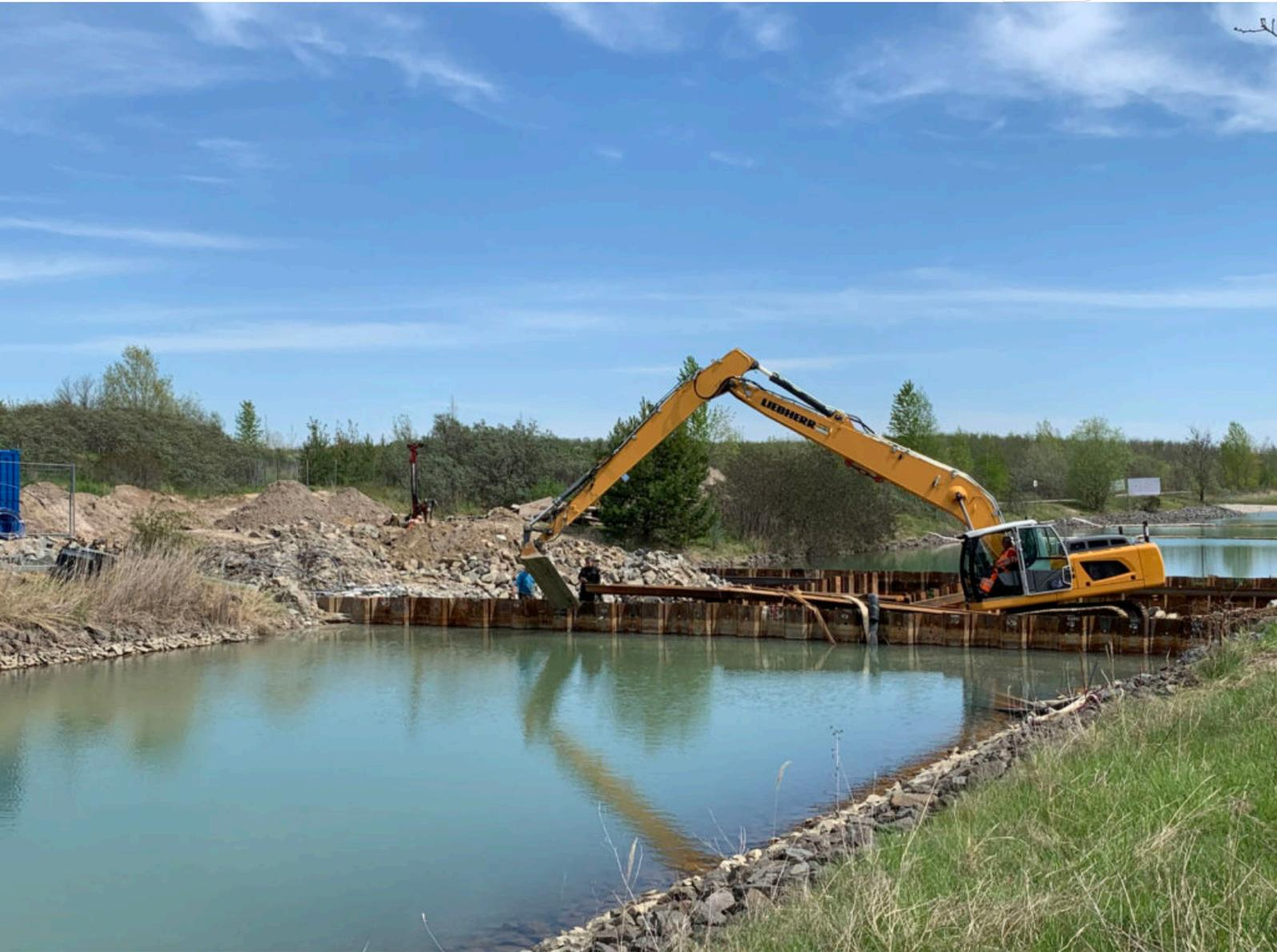
Auffüll- und Schweißarbeiten am Oberen Querbauwerk
