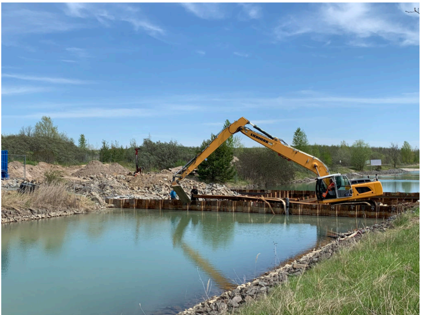
Auffüll- und Schweißarbeiten am Oberen Querbauwerk
