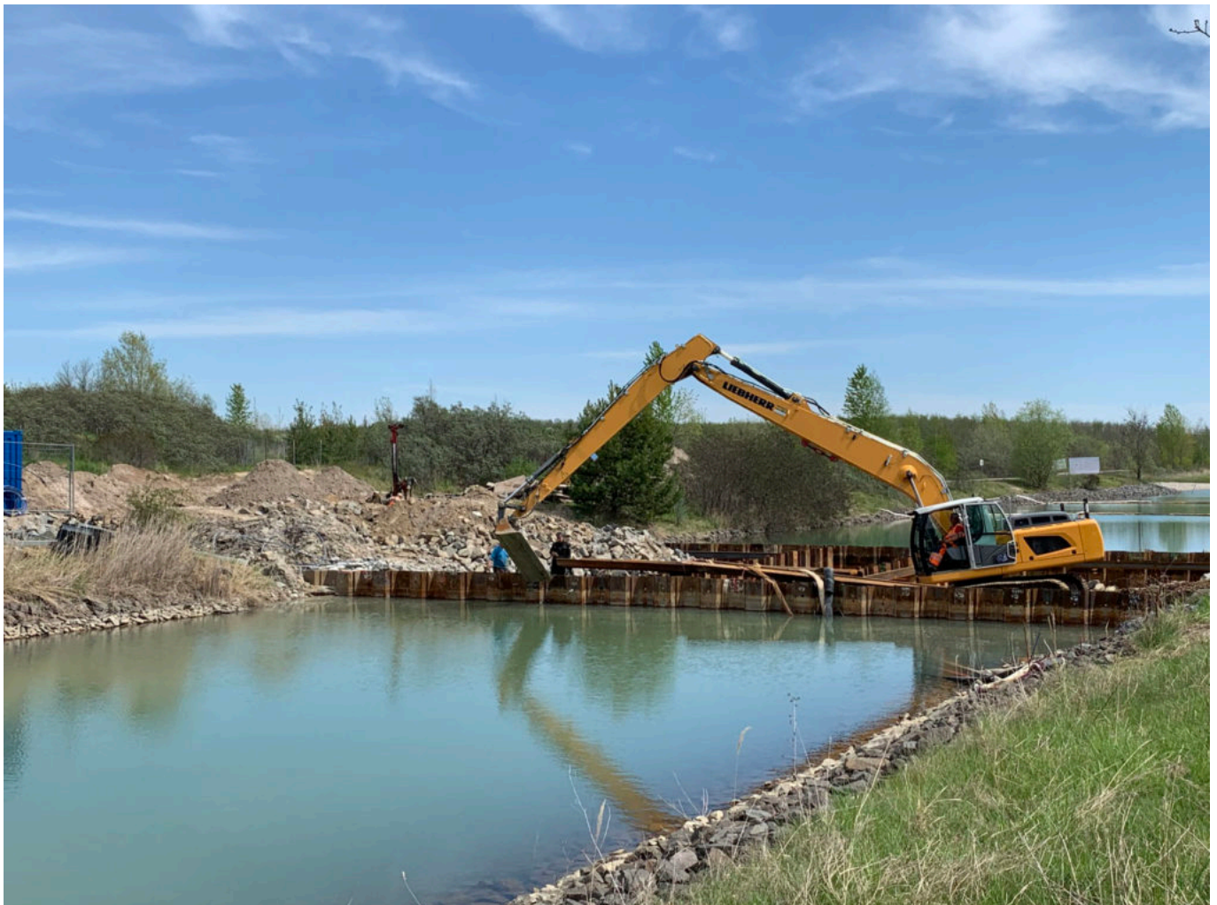
Auffüll- und Schweißarbeiten am Oberen Querbauwerk
