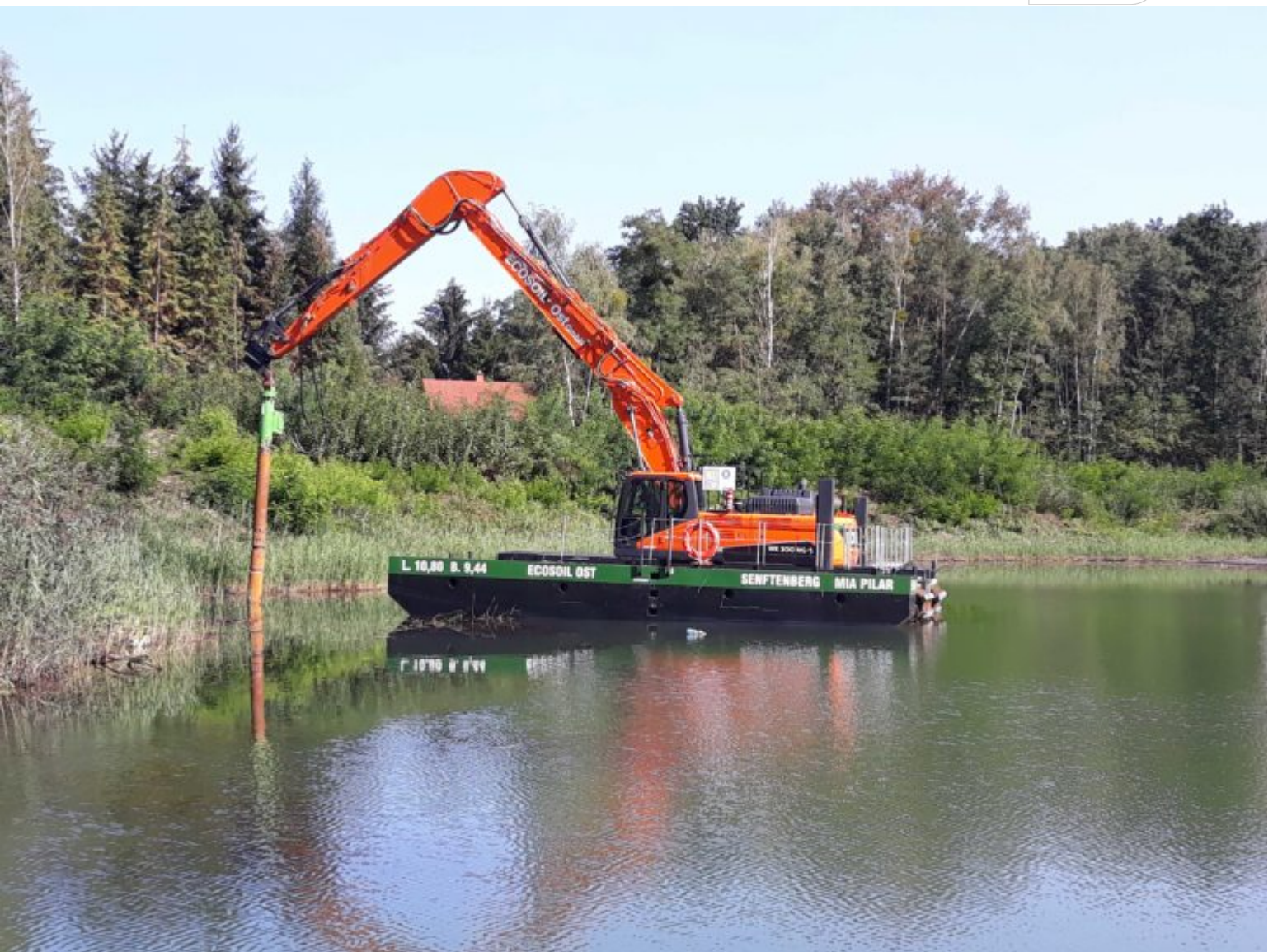
Mittels amphibischer Technik wird Neumanns Grube gesichert
