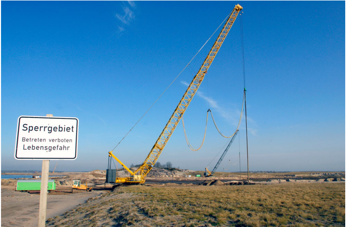
Sperrbereich im Sanierungsgebiet Schlabendorf-Süd
