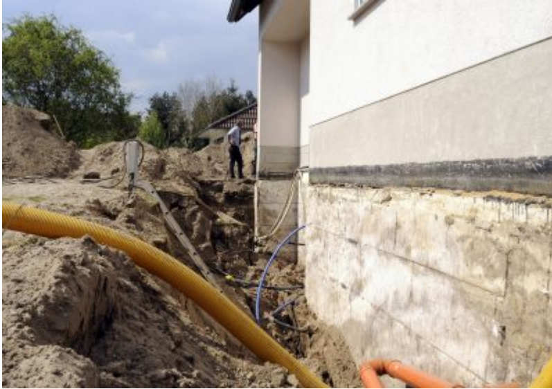
Hausanhebung zur Sicherung vor wieder ansteigendem Grundwasser
