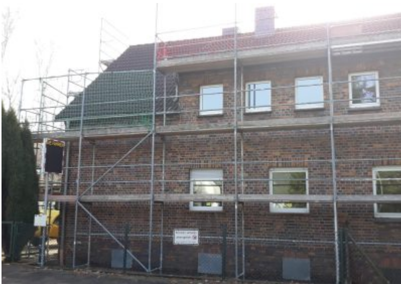
Vorbereitung einer Hausabtragung in Lauchhammer
