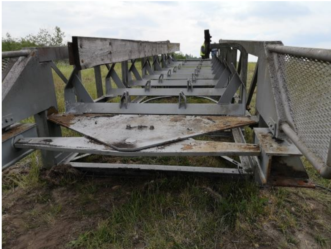
Auflaufbrücke steht am Lappwaldsee (Foto: LMBV)
