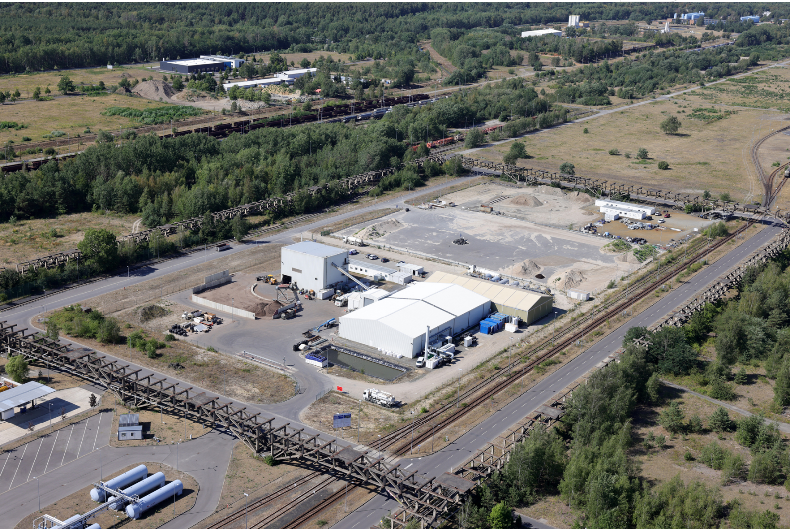
Blick auf die Vakuumthermische Reinigungsanlage (VTRA)
