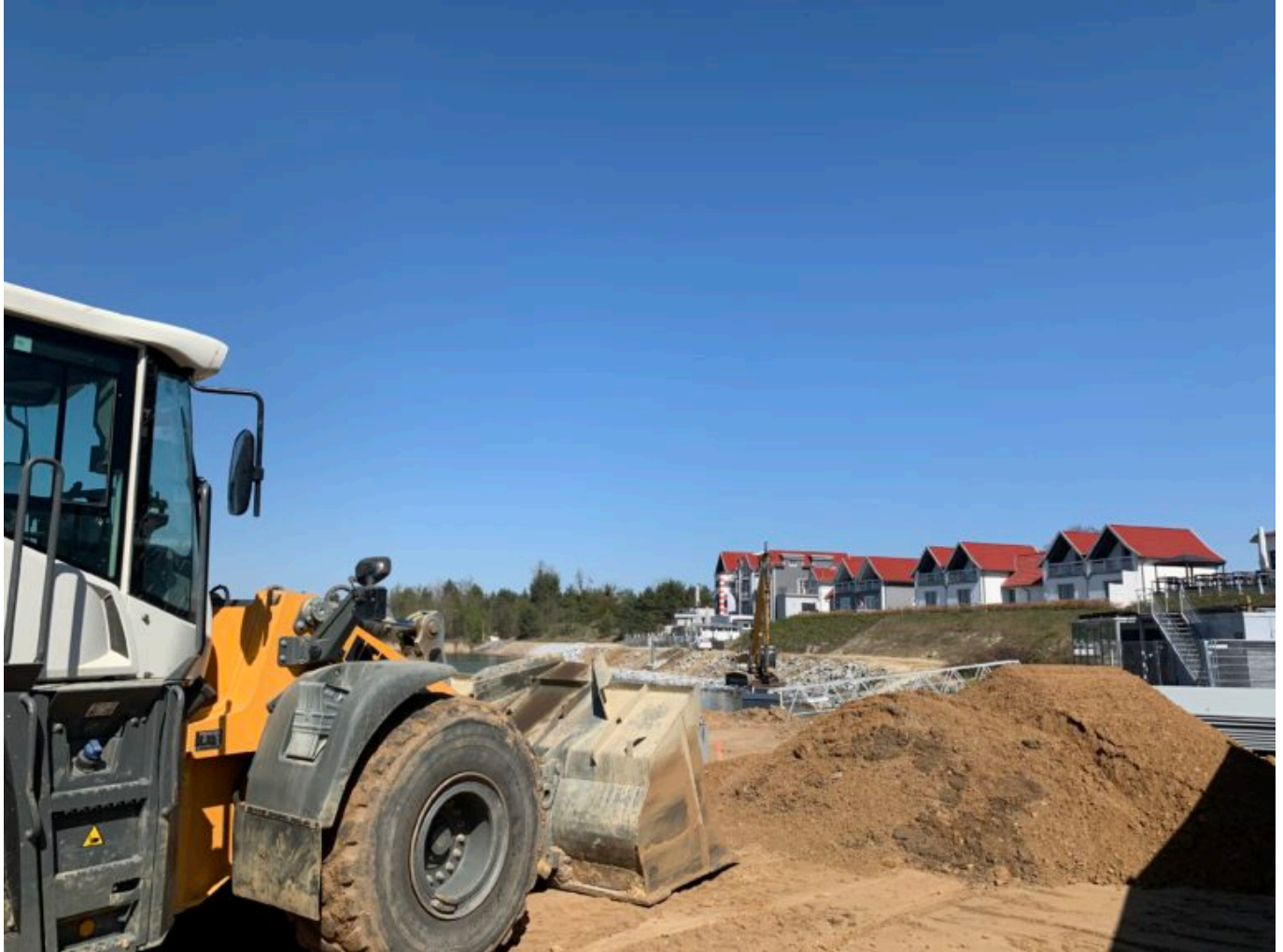
Blick auf den teilweise bereits mit Wasserbausteinen gesicherten Uferabschnitt
